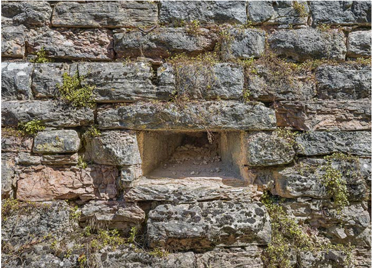
Ouverture de tir au flanc du bastion (galerie de contrescarpe).
