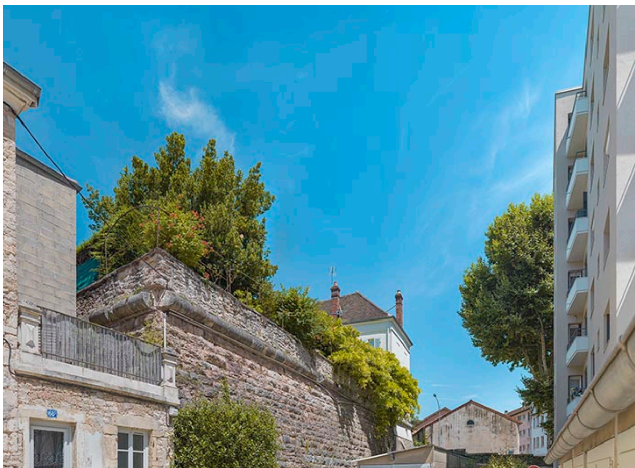
Angle sud de la face et du flanc au niveau du parapet.
