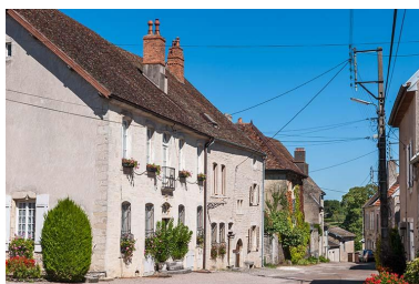
Vue générale depuis l'ouest Phot. Jérôme Mongreville IVR43_20137000202NUCA
