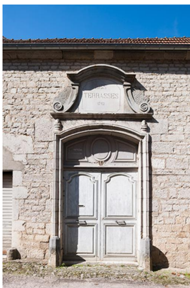
Porte du 6 rue du Bourg
