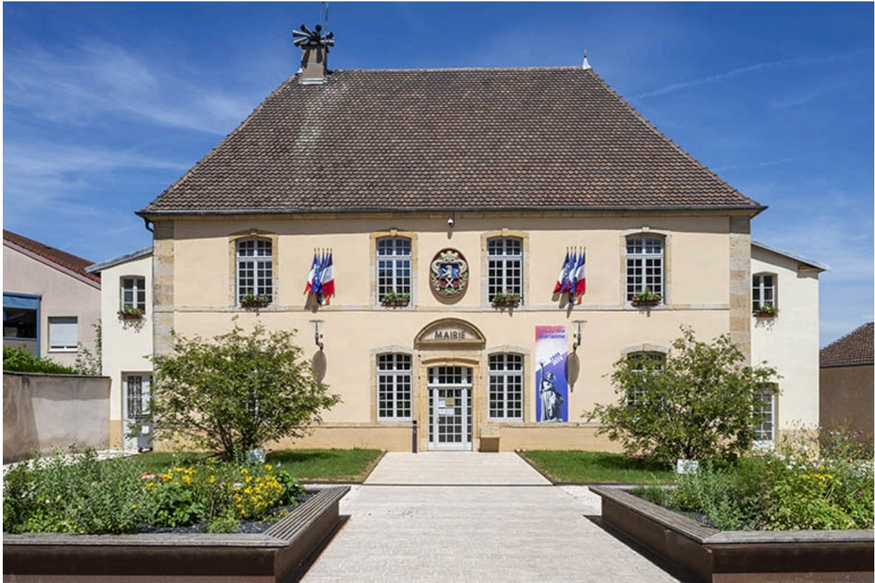
L'ensemble de la façade sud.
