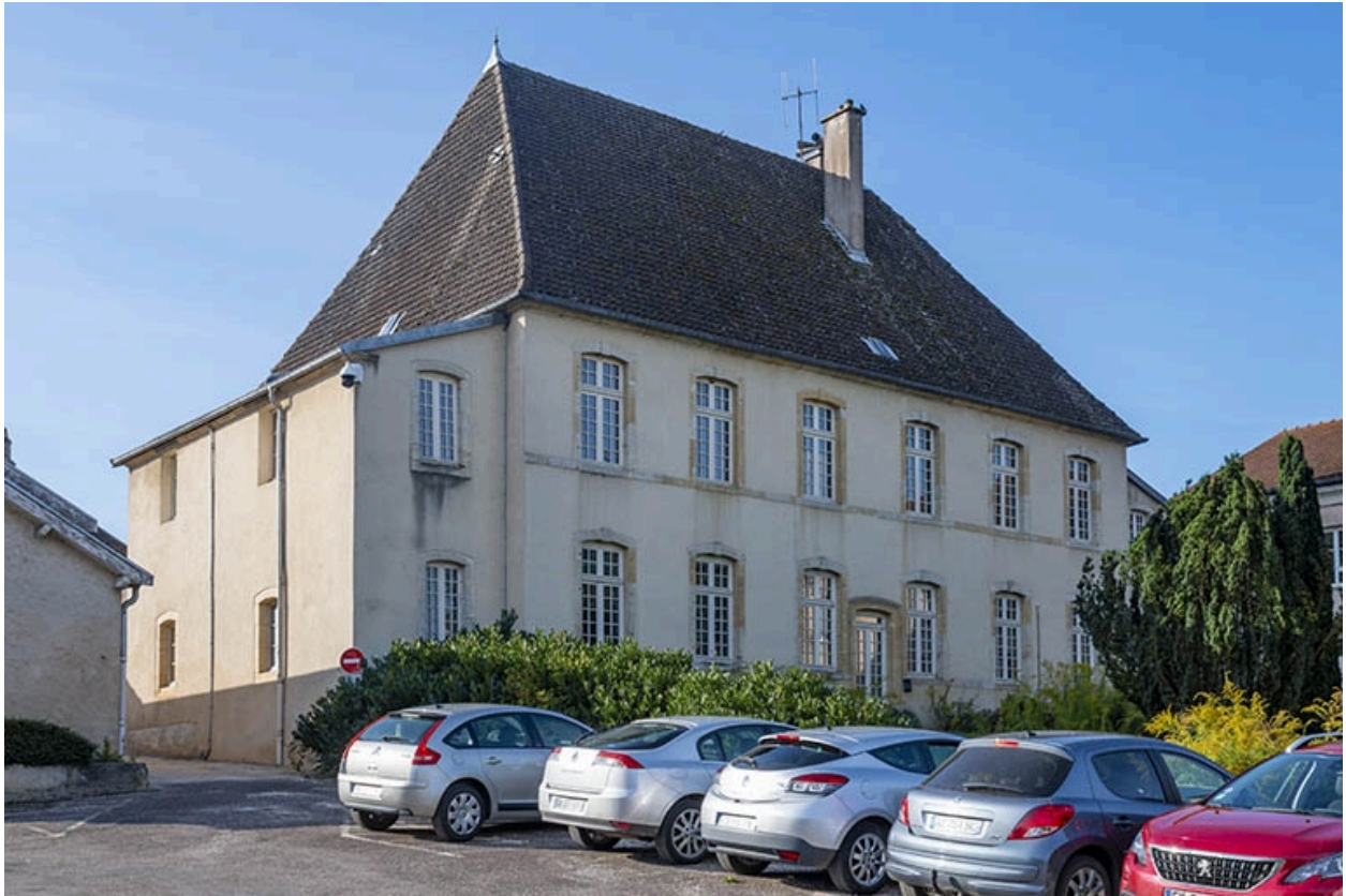
L'arrière, façade nord.
