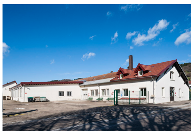
Usine originelle et extension, depuis l'est. Phot. Jérôme Mongreville IVR43_20162500314NUC4A
