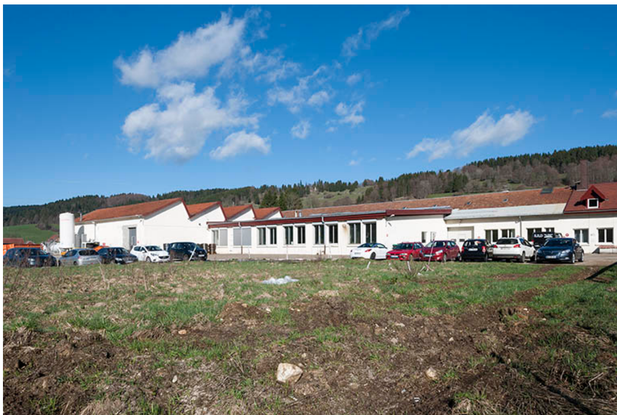
Vue depuis le sud-est.
