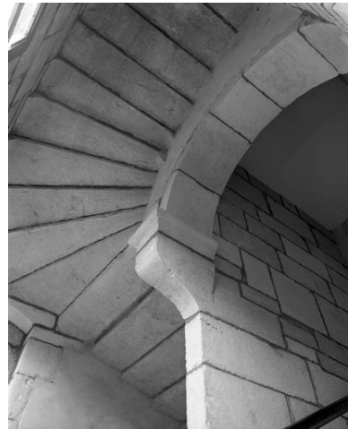
Détail d'une volée d'escalier. Phot. Yves Sancey IVR43_19917000003X
