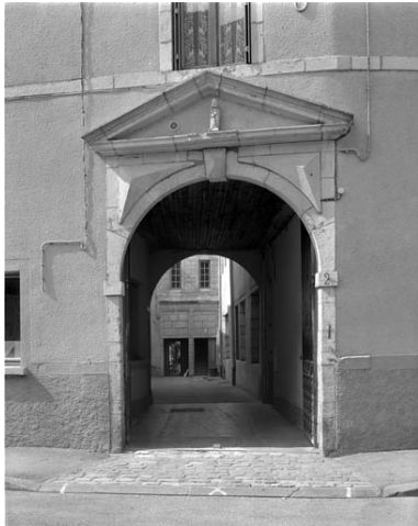
Portail d'entrée. Phot. Yves Sancey IVR43_19897000431V
