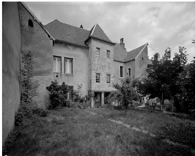
Façade postérieure. Phot. Yves Sancey IVR43_19917000001V
