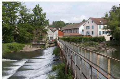
Passerelle sur le barrage situé près des ateliers municipaux, faubourg de Besançon. Phot. Jérôme Mongreville IVR43_20122500963NUC4A
