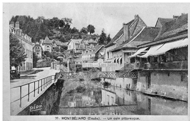
Montbéliard (Doubs). Un coin pittoresque [passerelle de l'hôtel du Lion Rouge, rue des Halles], début 20e siècle. Phot. IVR43_19862500142X
