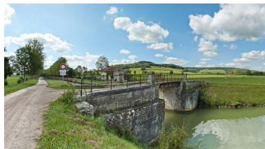
Vue du pont. Phot. Pierre-Marie Barbe-Richaud IVR26_20112103989NUC4AQ
