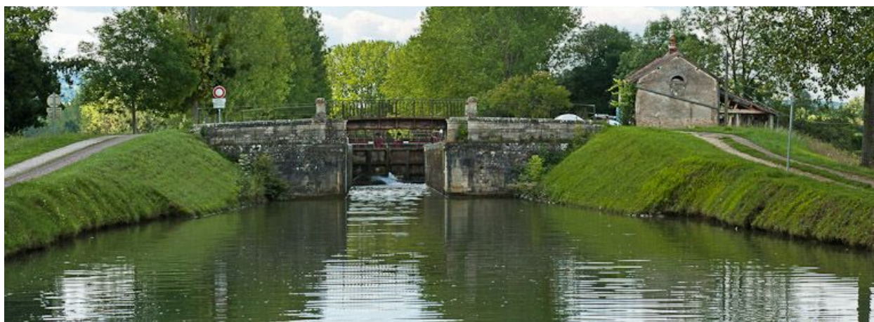
Vue du pont depuis l'aval.
