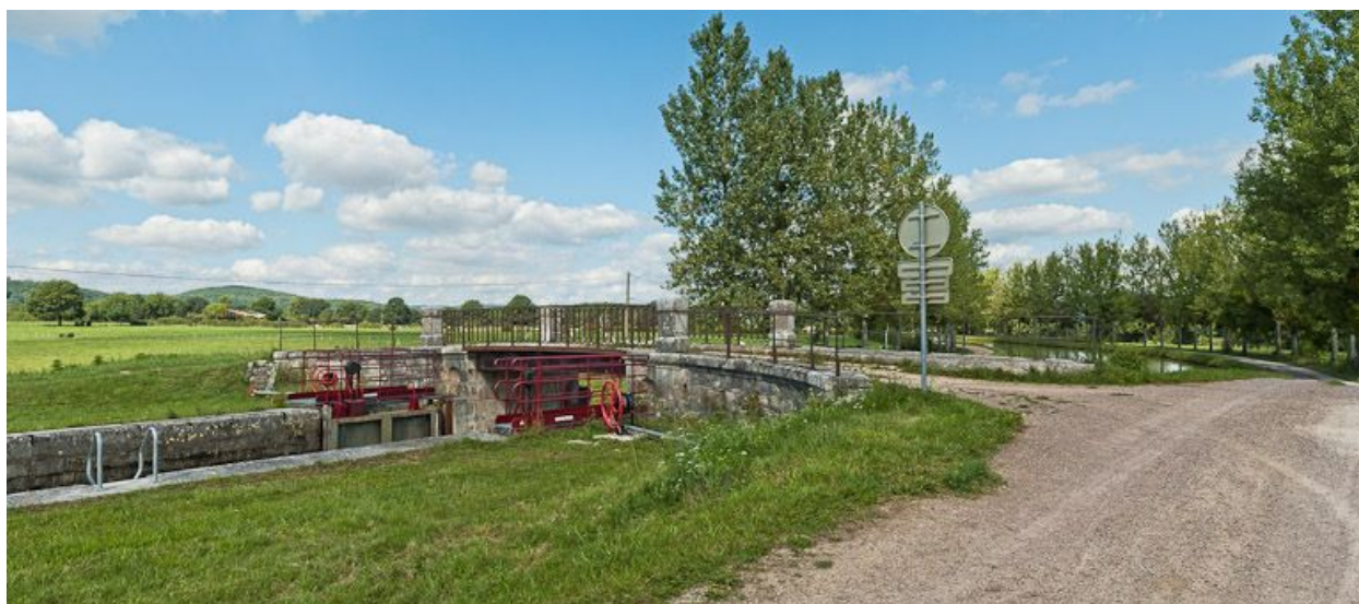
Vue du pont depuis l'amont.
