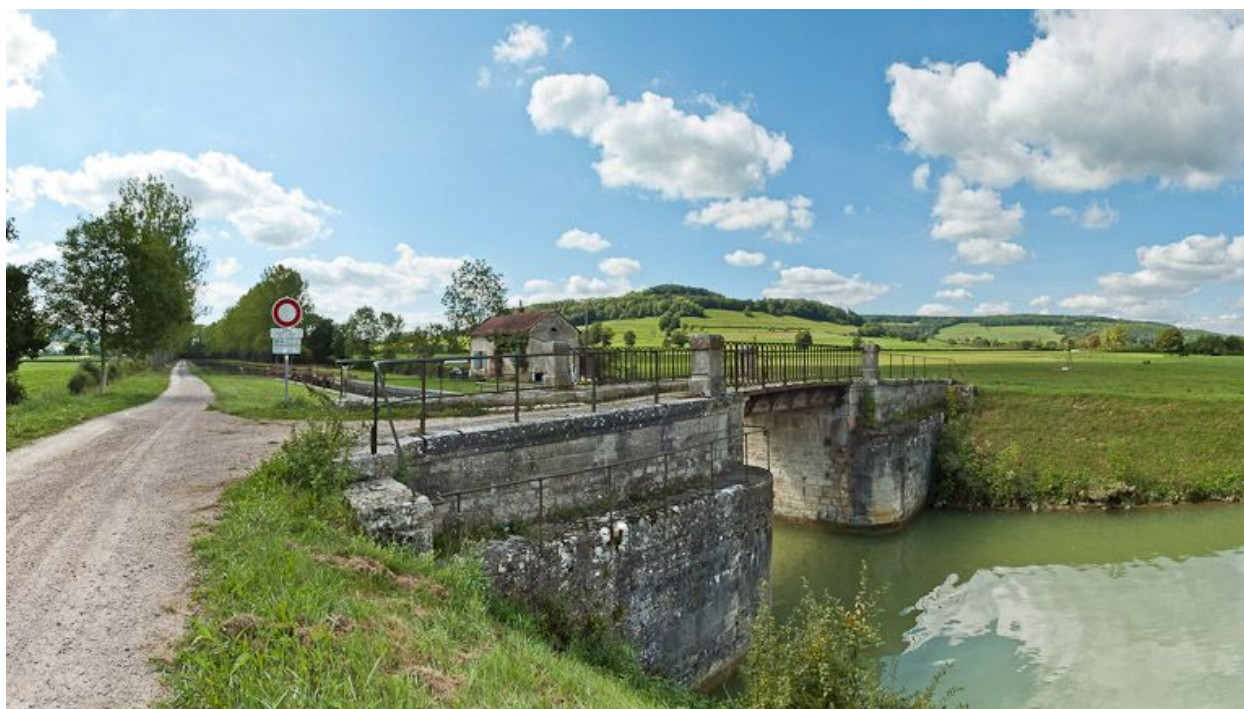
Vue du pont.
