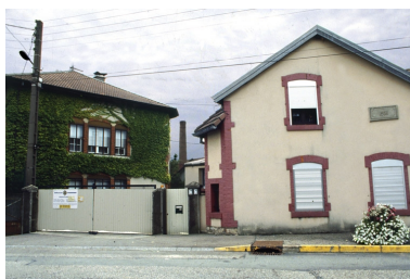
L'entrée de l'usine. Phot. Yves Sancey IVR43_20009000038ZA
