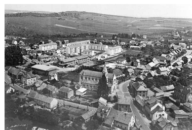
Danjoutin (Territoire de Belfort). Vue générale. Phot. Jérôme Mongreville IVR43_200190000091X
