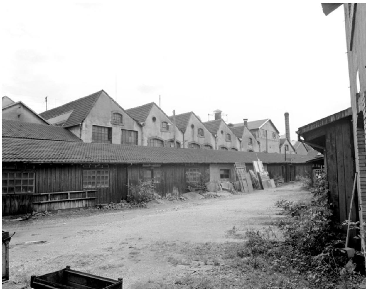
Les ateliers de la fonderie en 1981.SRI. Enquête régionale sur les bâtiments industriels (1979-1981).
