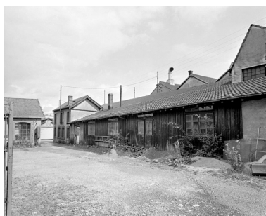
La cour de la fonderie en 1981.SRI. Enquête régionale sur les bâtiments industriels (1979-1981). Phot. Yves Sancey IVR43_19819000081X
