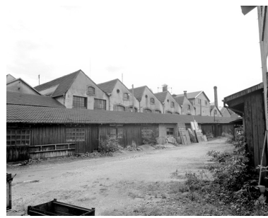
Les ateliers de la fonderie en 1981.SRI. Enquête régionale sur les bâtiments industriels (1979-1981). Phot. Yves Sancey IVR43_19819000082X
