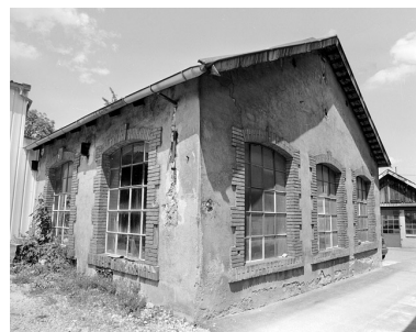
Magasins généraux : atelier (?). Phot. Yves Sancey IVR43_20029000322X
