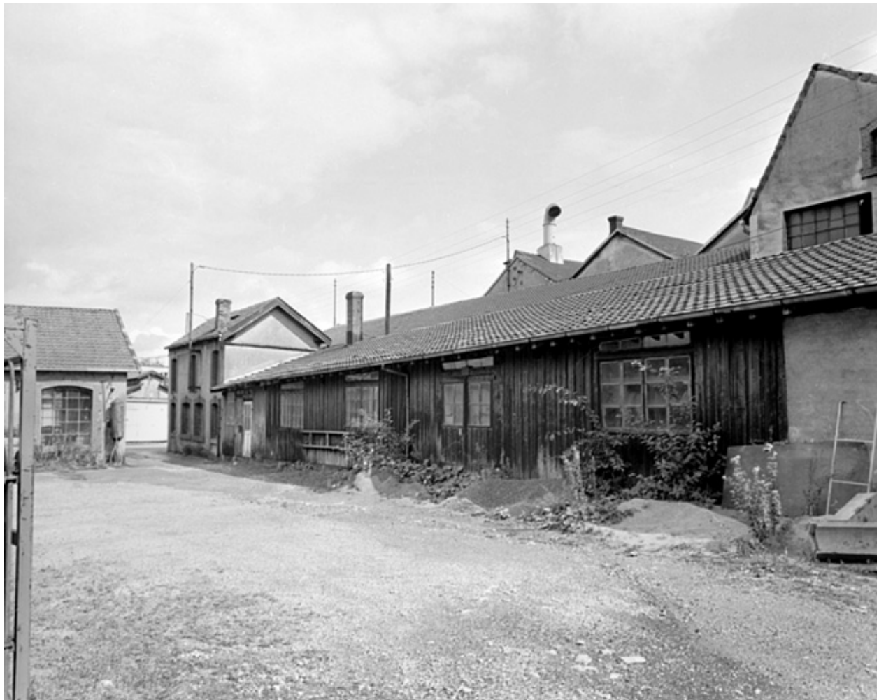
La cour de la fonderie en 1981.SRI. Enquête régionale sur les bâtiments industriels (1979-1981).
