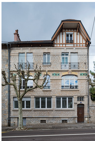
Vue de face. Phot. Jérôme Mongreville IVR43_20182500502NUC4A
