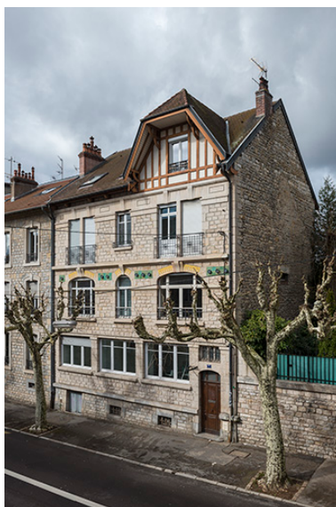
Vue de trois quarts droite. Phot. Jérôme Mongreville IVR43_20182500500NUC4A
