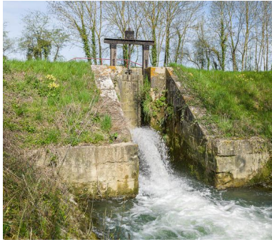
Le déversoir en contrebas du canal.
