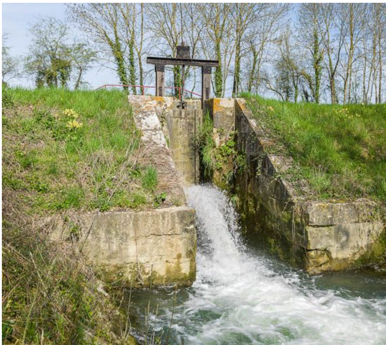
Le déversoir en contrebas du canal.
