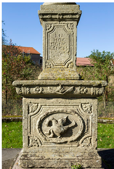
La base et le bas de la croix. Phot. Sonia Dourlot IVR43_20157000666NUC2A
