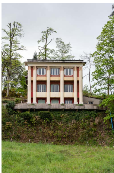
Façade nord, vue de face. Phot. Pierre-Marie Barbe-Richaud IVR26_20195800011NUC4A
