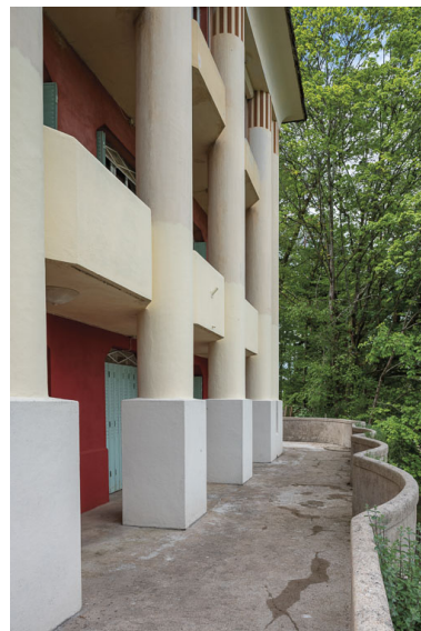
Terrasse de la façade nord. Phot. Pierre-Marie Barbe-Richaud IVR26_20195800228NUC4A
