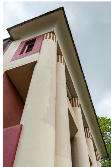
Corniche surmontant le troisième niveau de la façade nord. Phot. Pierre-Marie Barbe-Richaud IVR26_20195800229NUC4A
