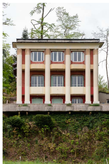
Façade nord, vue de face. Phot. Pierre-Marie Barbe-Richaud IVR26_20195800012NUC4A
