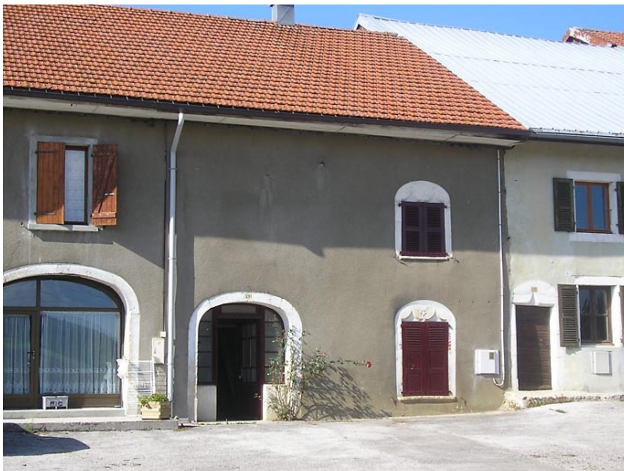
Vue de la façade antérieure.
