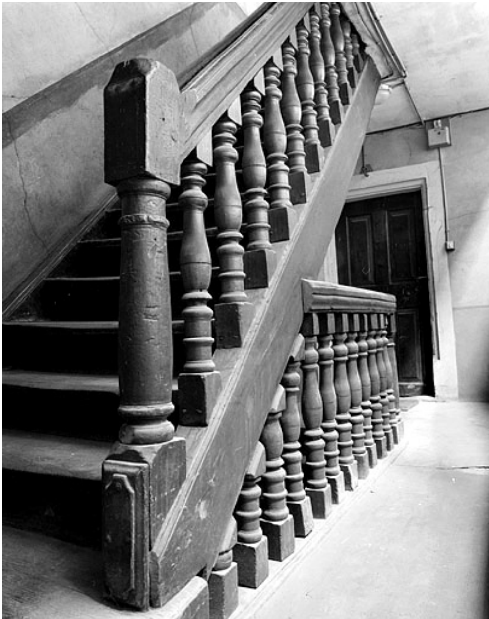
Escalier vu au niveau du premier étage.
