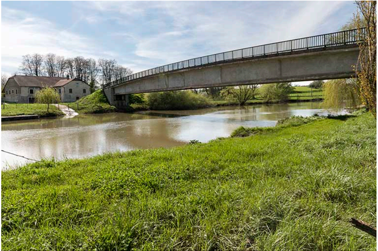
Franchissement de la Saône : pont de Fouchécourt.
