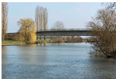
Franchissement de la Saône : pont de Fouchécourt. Phot. Sonia Dourlot IVR43_20167000315NUC4A
