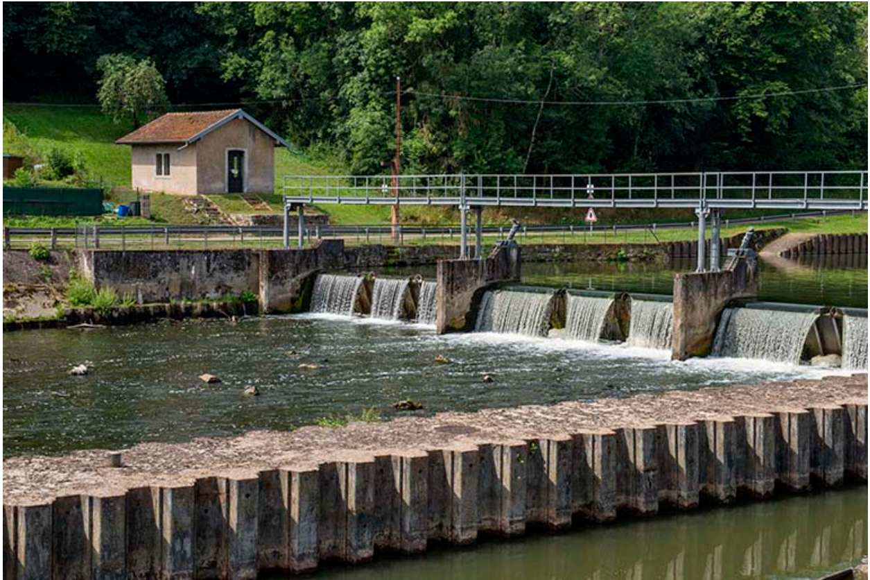
Le barrage mobile.
