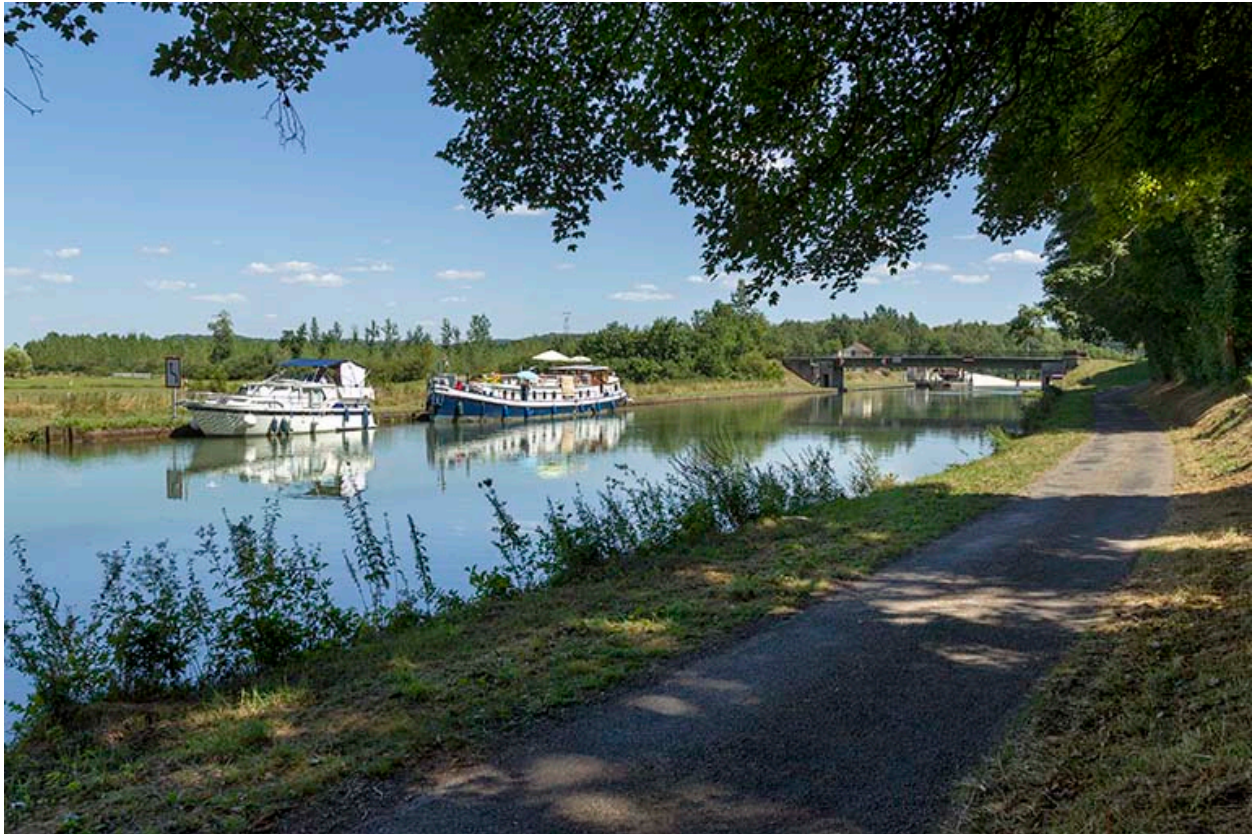
Vue éloignée du site d'écluse en amont du pont depuis la rive droite.
