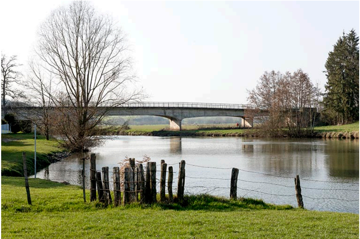
Franchissement de la Saône : pont routier à Port d'Atelier.
