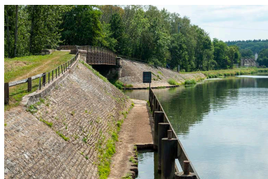
Perrée en aval de l'écluse et le pont de la Lanterne. Phot. Jérôme Mongreville
