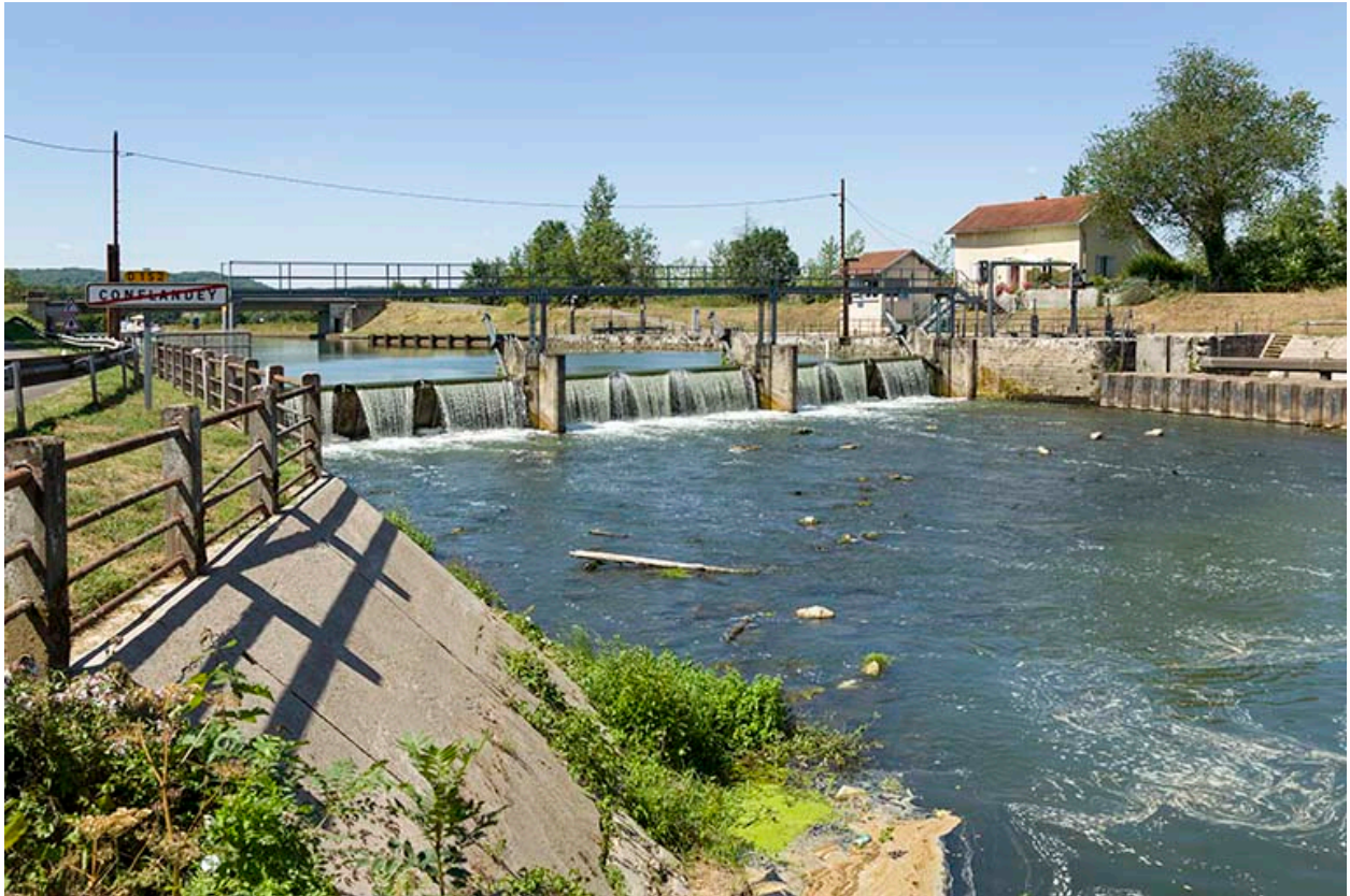
Barrage de Conflandey vu de la rive droite en aval.
