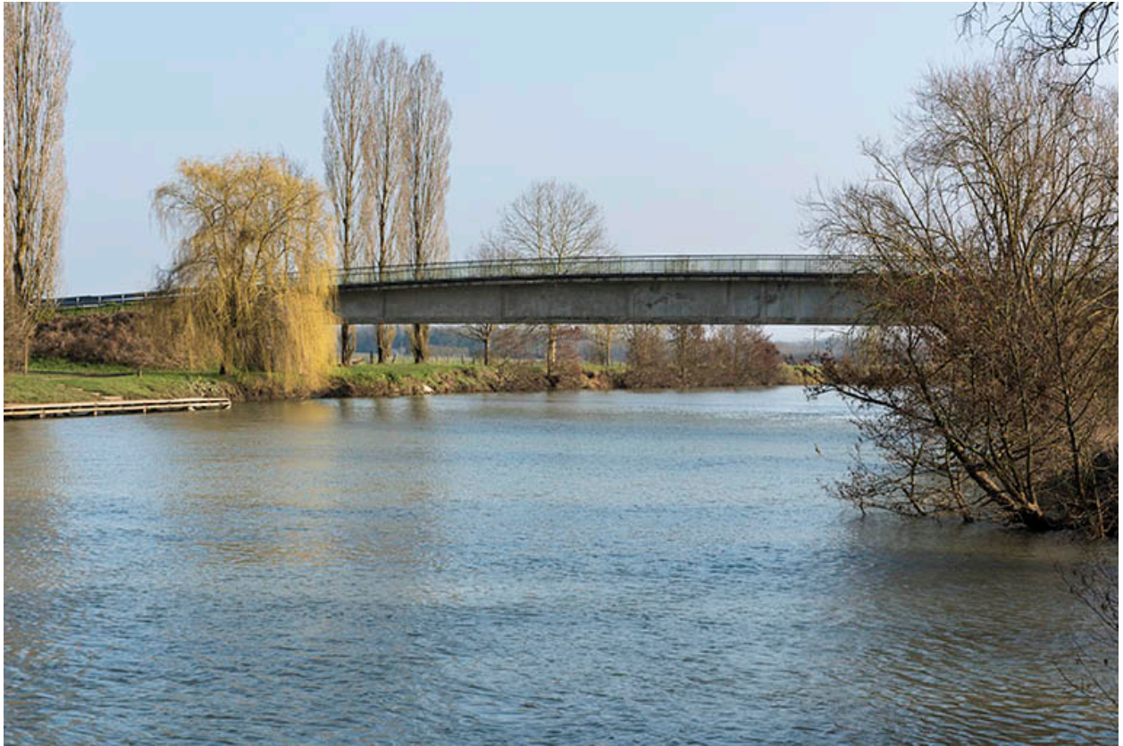
Franchissement de la Saône : pont de Fouchécourt.
