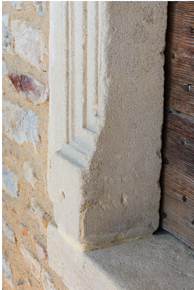
Détail d'une baie moulurée du XVI e siècle, à l'étage de la maison Phot. Pierre-Marie Barbe-Richaud IVR26_20197100253NUC4A
