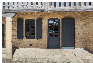
Détail du rez-de-chaussée de la façade antérieure de la maison : baies en arc segmentaire (milieu du XVIIIe siècle) Phot. Pierre-Marie Barbe-Richaud IVR26_20197100254NUC4A
