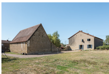
Vue d'ensemble de la ferme au nord Phot. Pierre-Marie Barbe-Richaud IVR26_20197100246NUC4A
