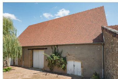
Vue de la façade postérieure de la grange. A droite, une portion du mur du bâtiment du cuvage, construit au sud de la grange, apparaît. Phot. Pierre-Marie Barbe-Richaud IVR26_20197100256NUC4A
