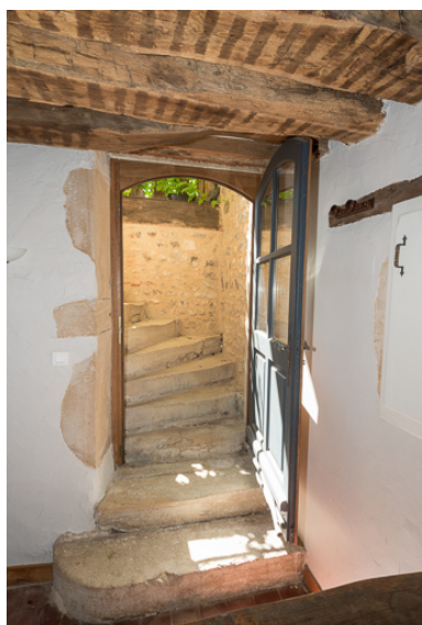
Escalier donnant accès à la galerie Phot. Pierre-Marie Barbe-Richaud IVR26_20197100247NUC4A
