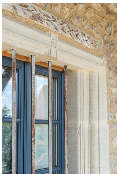
Détail d'une baie, à l'étage de la maison. D'époque Renaissance, cette baie provient vraisemblablement de l'ancien château de Vauban, détruit au début du XVIIIe siècle, et a été utilisée en emploi. Phot. Pierre-Marie Barbe-Richaud IVR26_20197100250NUC4A
