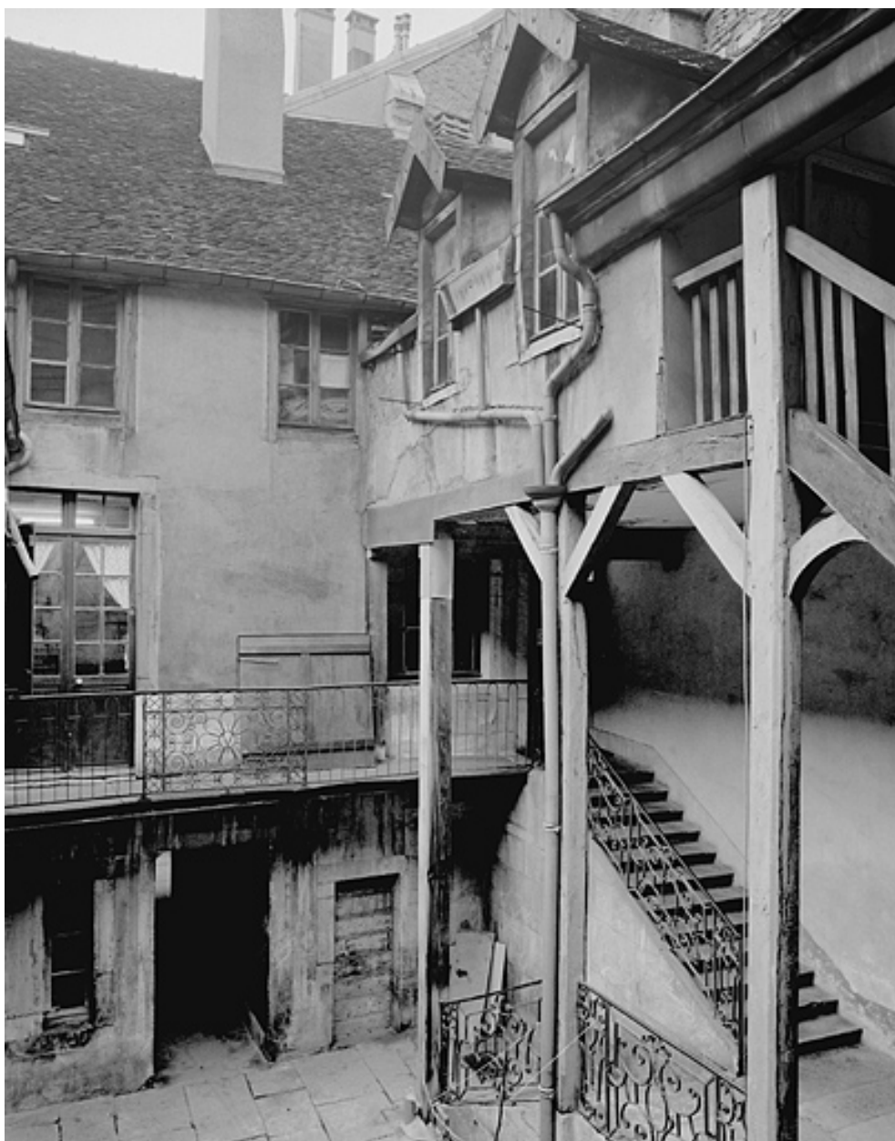
Vue de la cour intérieure avec l'escalier.
