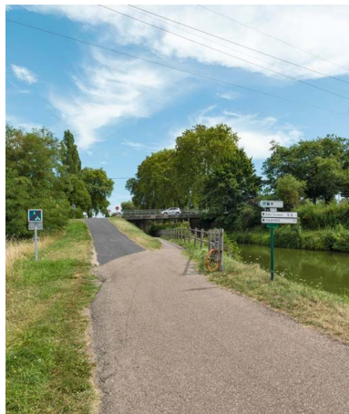
Vue d'ensemble du pont.
