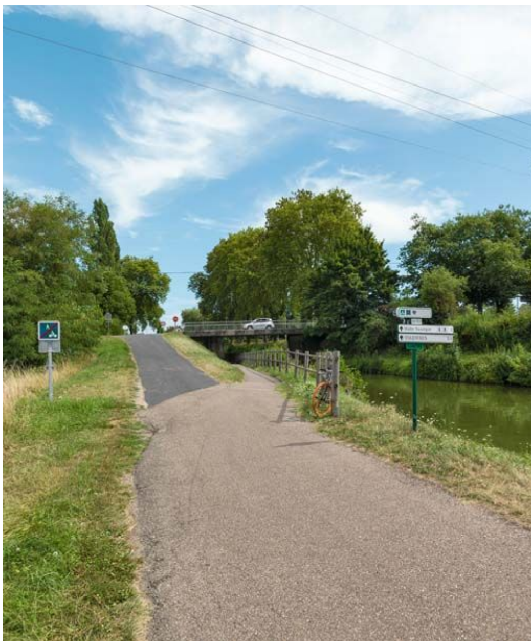
Vue d'ensemble du pont.
