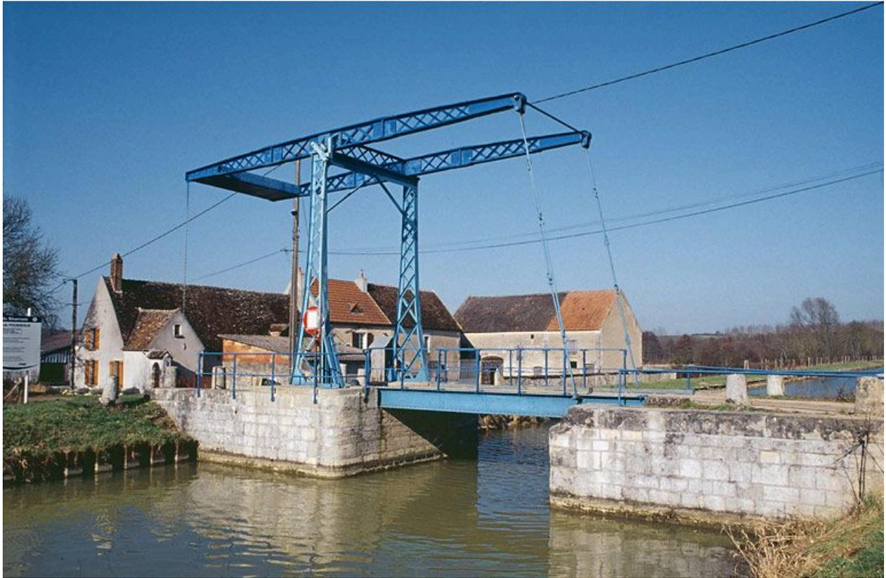
Pont mobile dit pont-levis à flèches de Pousseaux.
