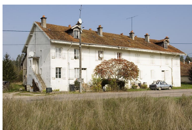
Maison B de la cité ouvrière. Phot. Jérôme Mongreville IVR43_20077000556NUCA
