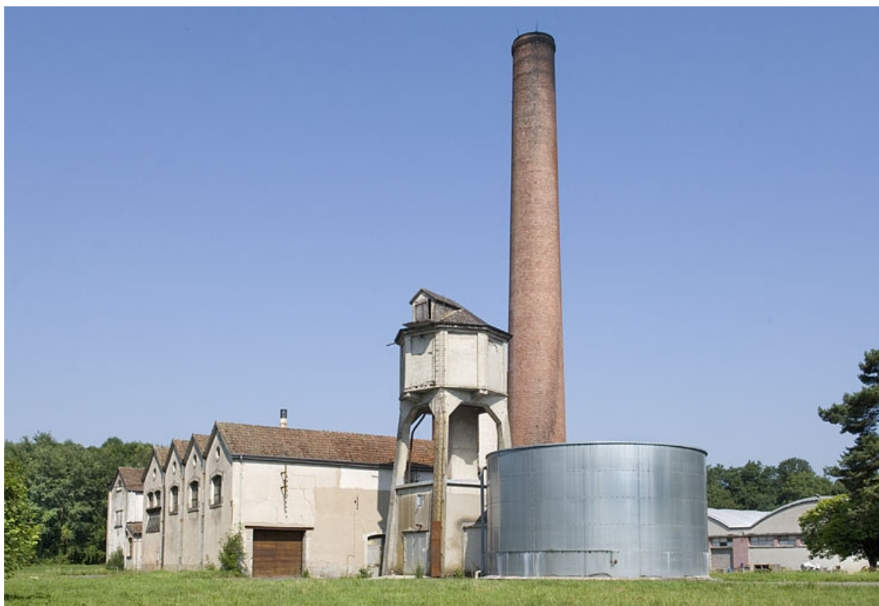
Chaufferie, réservoirs industriels et cheminée vus de trois quarts droite.
