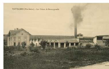
Vauvillers (Hte-Saône). - Les usines de Demangevelle. Phot. Jérôme Mongreville IVR43_20067000197NUCA
