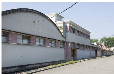
Façade nord de l'atelier de filature. Phot. Jérôme Mongreville IVR43_20097000730NUC2A
