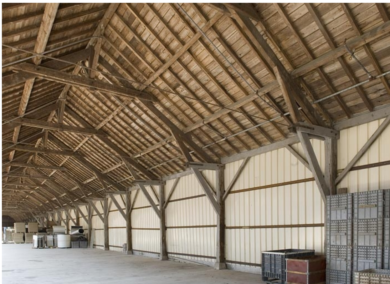
Fermes de la charpente de l'entrepôt industriel.
