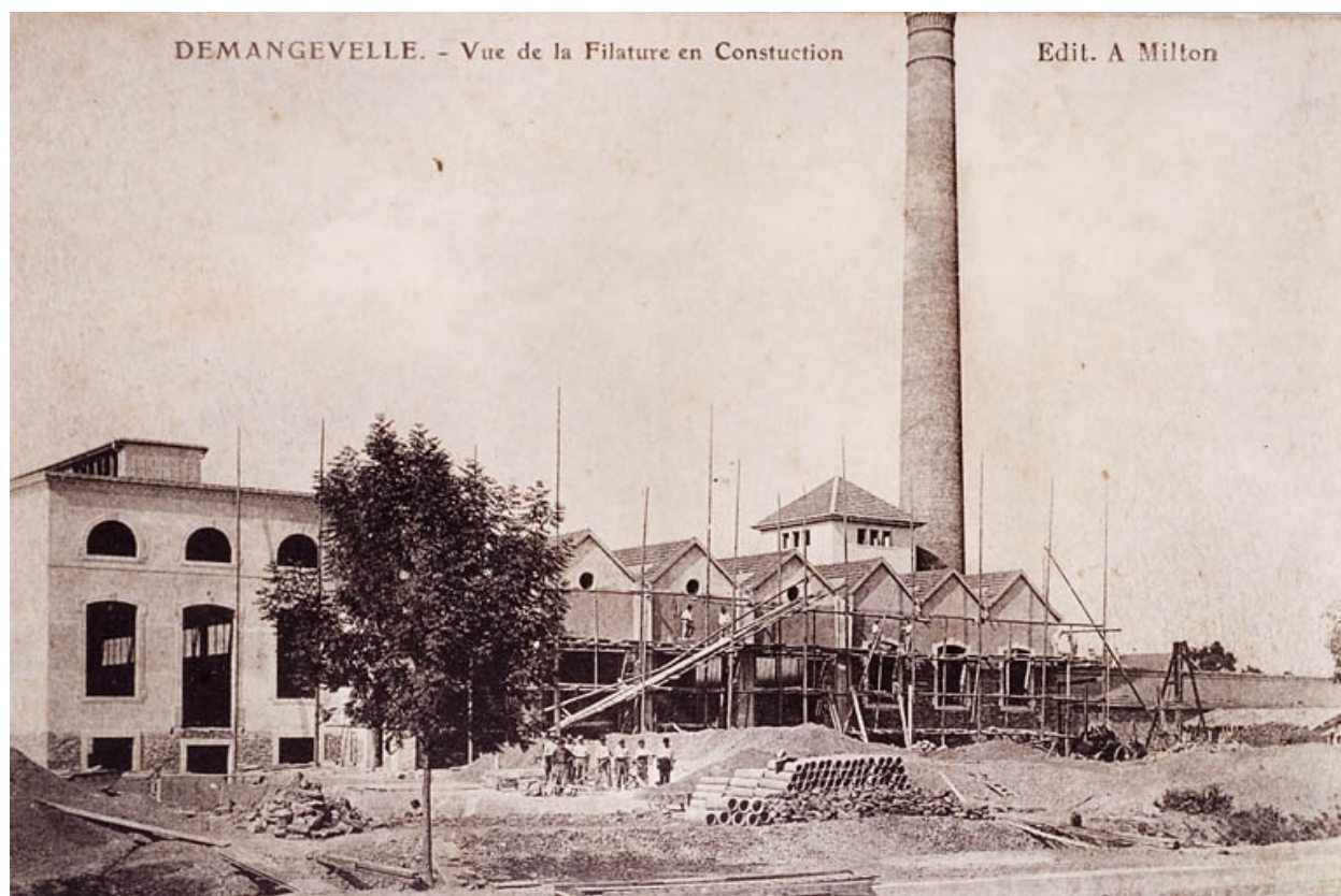
Demangevelle. - Vue de la filature en construction.
