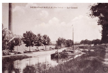
Demangevelle (Hte-Saône) - Le canal. Phot. Jérôme Mongreville IVR43_20077000685NUCA
