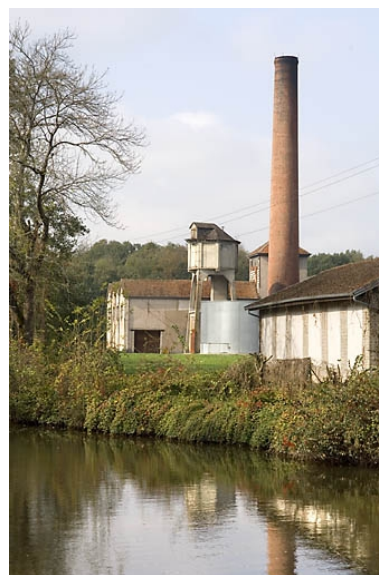
Chaudière, château d'eau et cheminée depuis le sud-est. Phot. Jérôme Mongreville IVR43_20077000559NUCA
