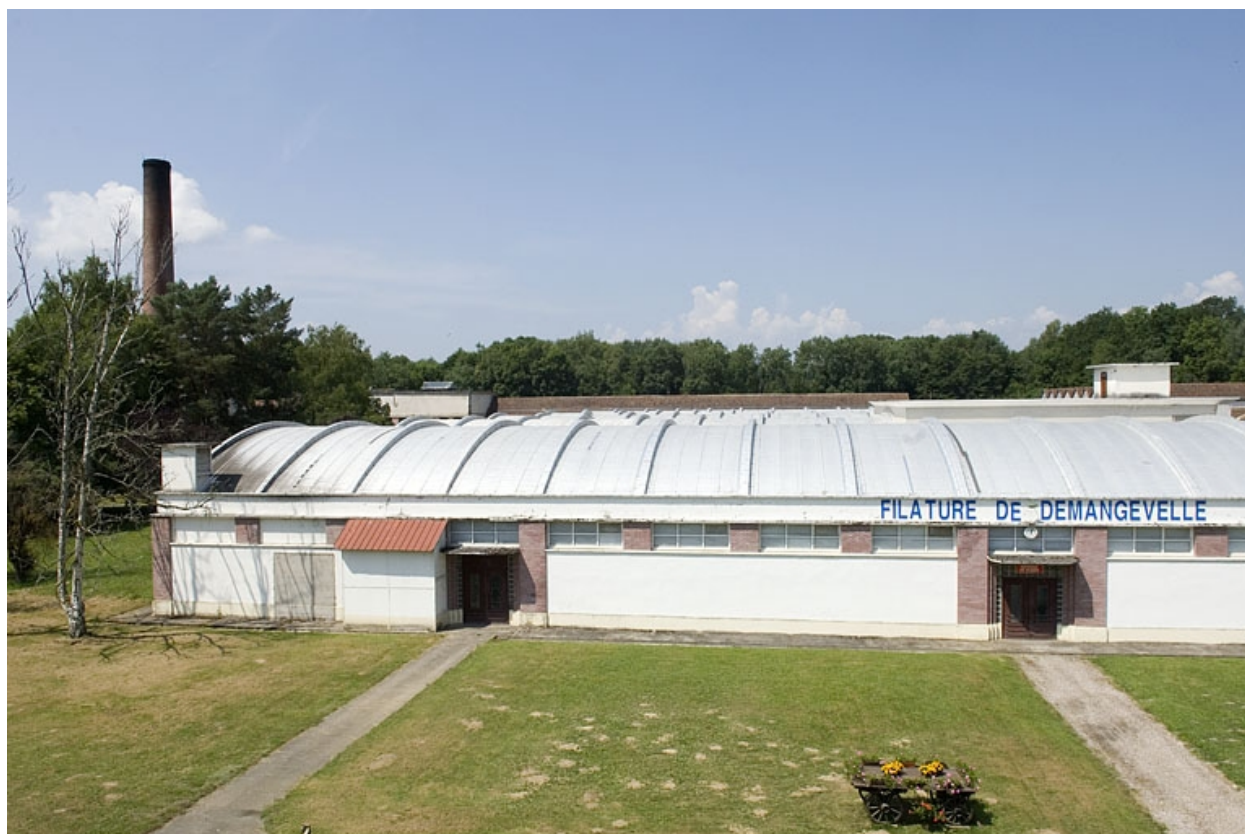
Vue plongeante sur l'atelier de filature.
