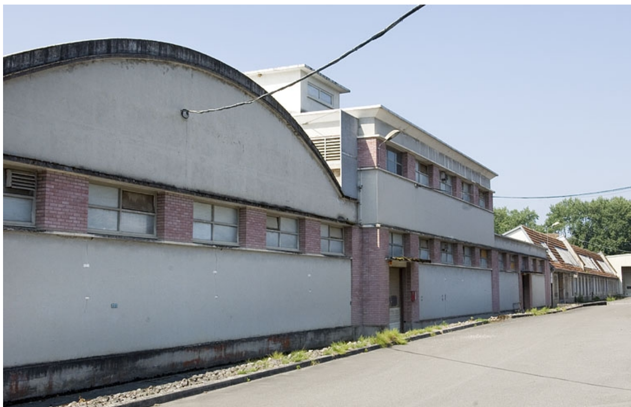
Façade nord de l'atelier de filature.
