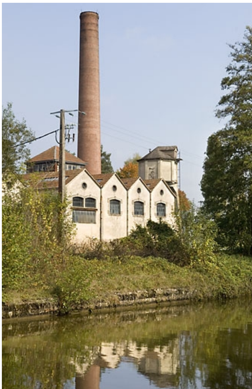
Bâtiments techniques vus de trois quarts.
