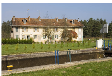
Maison C de la cité ouvrière. Phot. Jérôme Mongreville IVR43_20077000555NUCA
