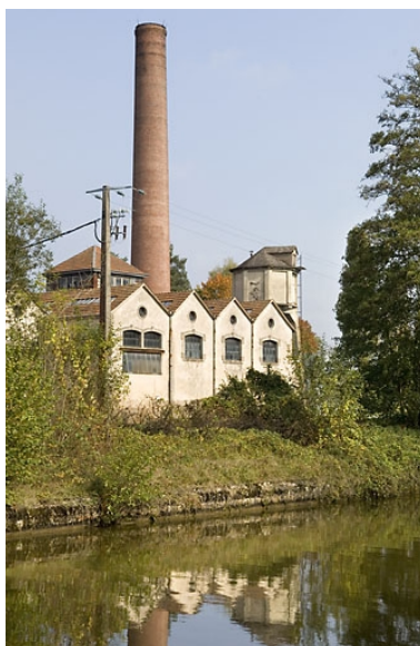
Bâtiments techniques vus de trois quarts. Phot. Jérôme Mongreville IVR43_20077000563NUCA
