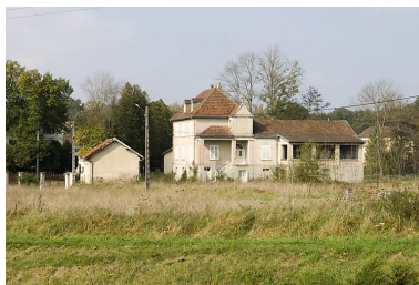
La garderie d'enfants, depuis l'est. Phot. Jérôme Mongreville IVR43_20077000550NUCA
