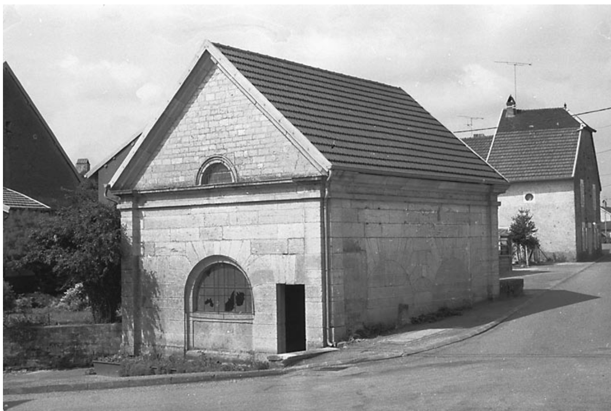
Vue d'ensemble depuis la place de l'église.
