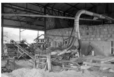
La machine à apprêter les traverses. Phot. Laurent Poupard IVR43_19883900333Z
