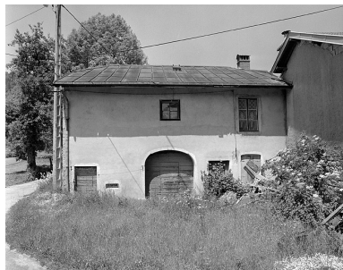
Façade antérieure. Phot. Jérôme Mongreville IVR43_19973900709X
