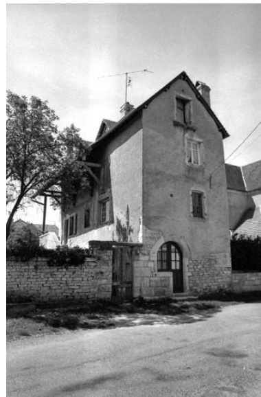
Vue d'ensemble, trois quarts gauche. Phot. Bernard Lardière IVR43_19817000512Z
