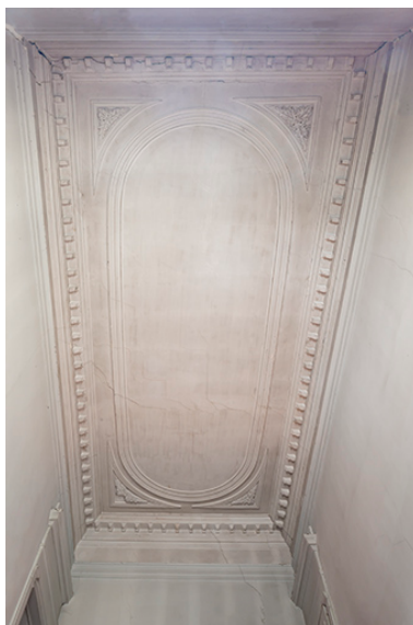
Plafond de la cage d'escalier. Phot. Jérôme Mongreville IVR43_20233900690NUC4A
