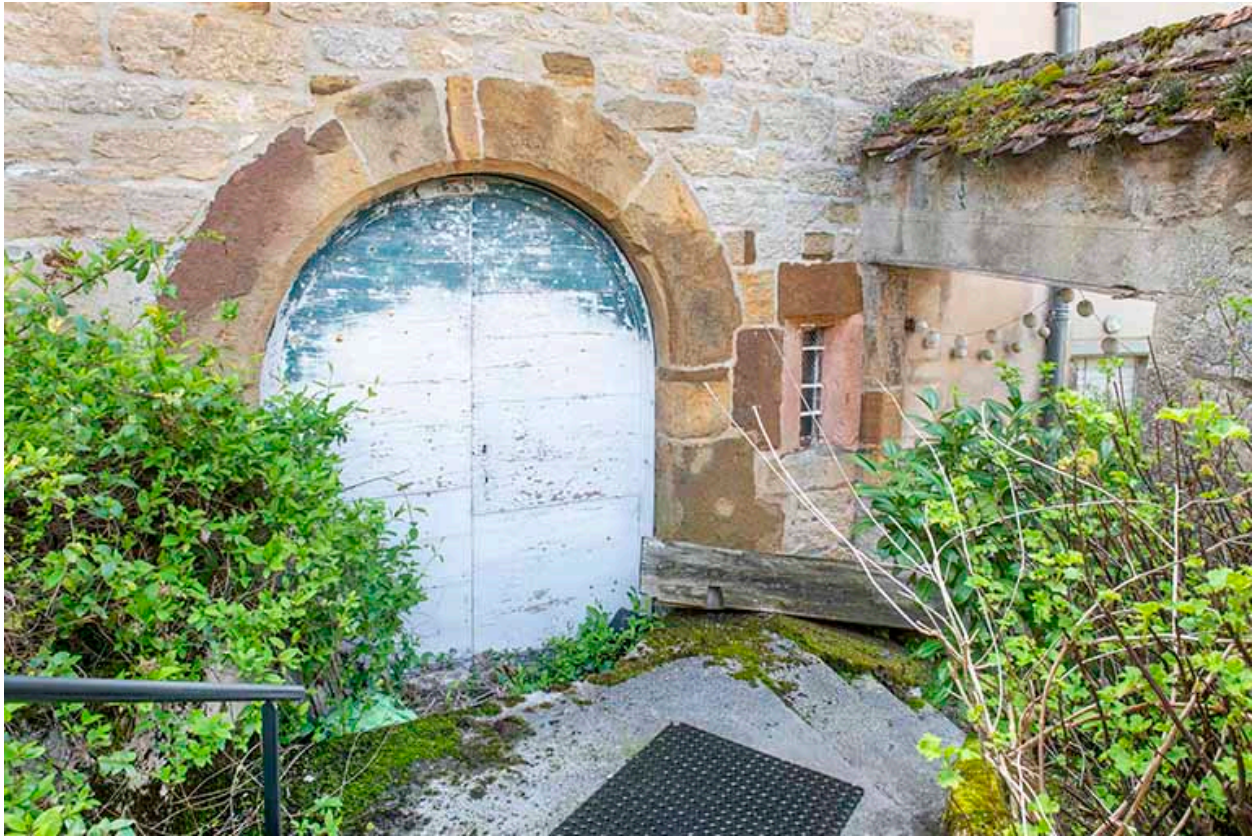
Porte de cave (façade nord).
