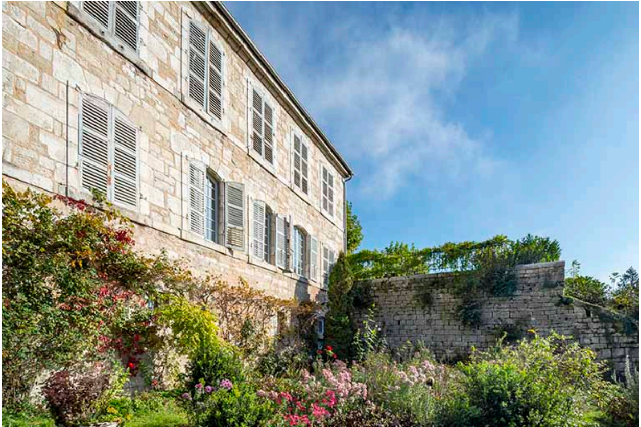
Façade ouest vue de trois quarts droite.
