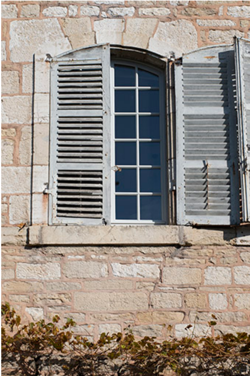
Fenêtre du rez-de-chaussée (façade ouest).
