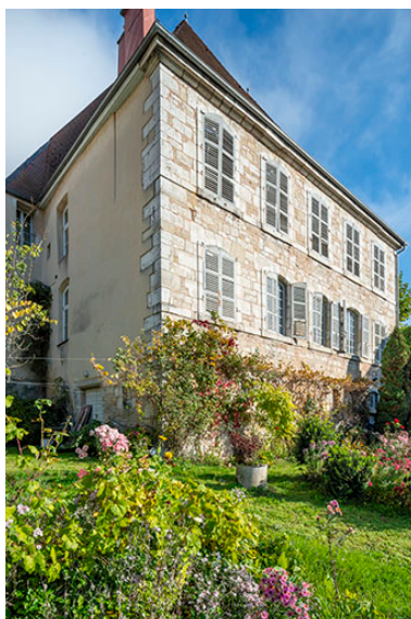
Vue de trois quarts en contre-plongée, depuis le jardin. Phot. Jérôme Mongreville IVR43_20233900684NUC4A
