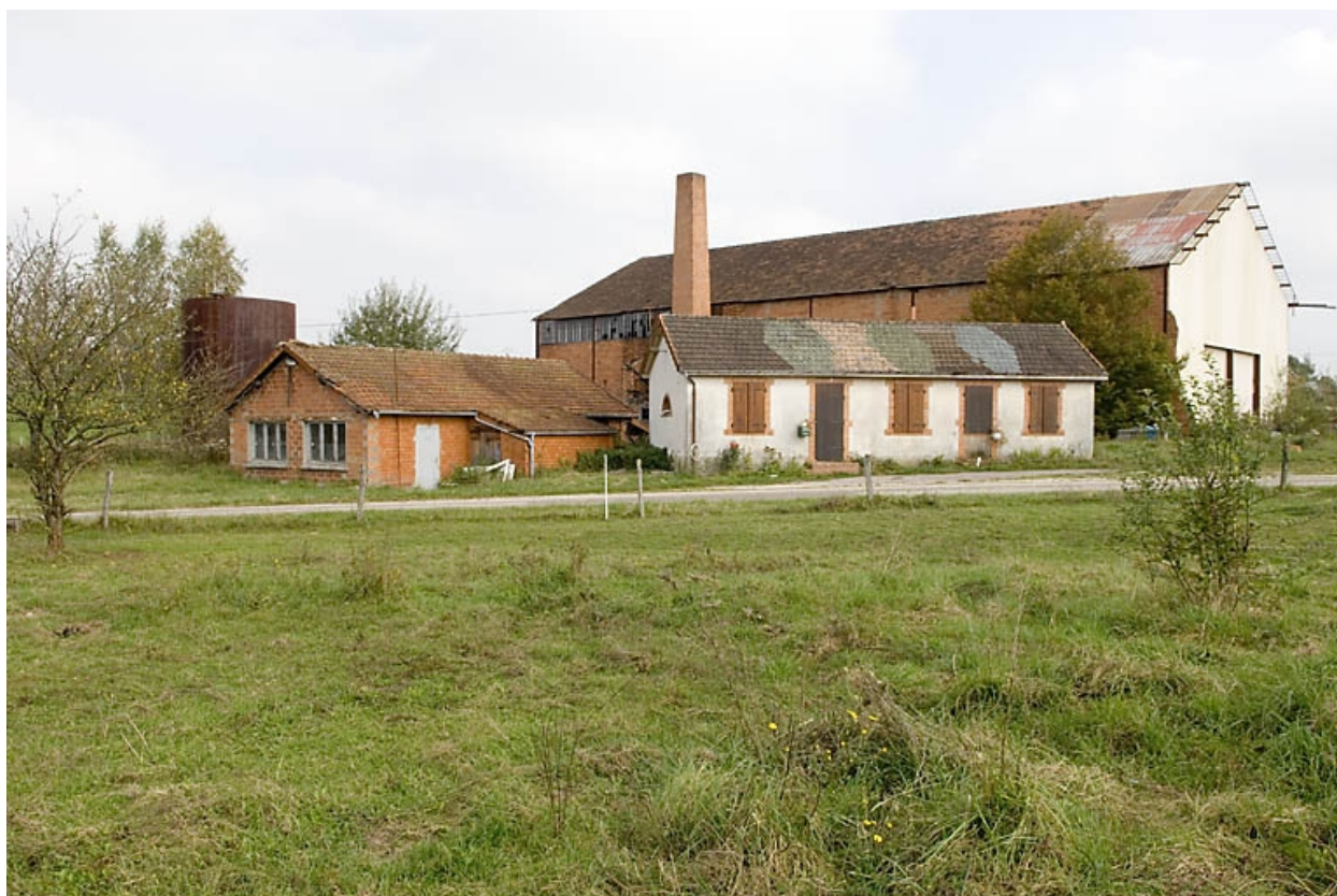
Vue d'ensemble depuis l'ouest.
