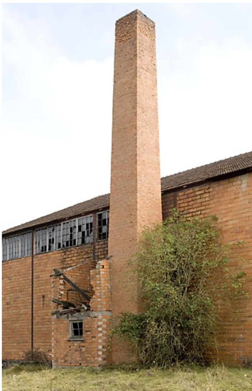
Cheminée et atelier de fabrication.
