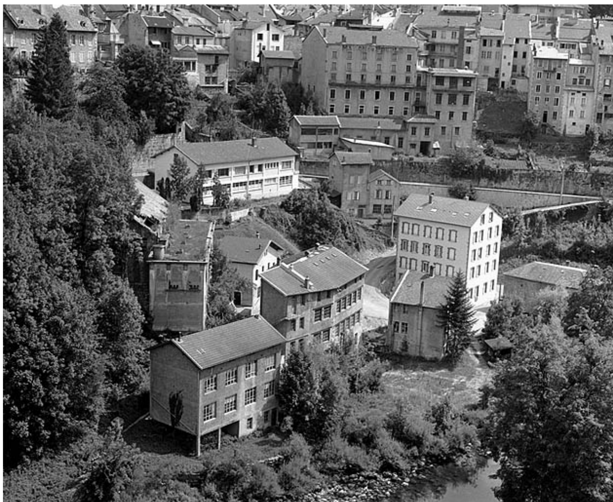
Vue d'ensemble rapprochée depuis le nord-ouest.
