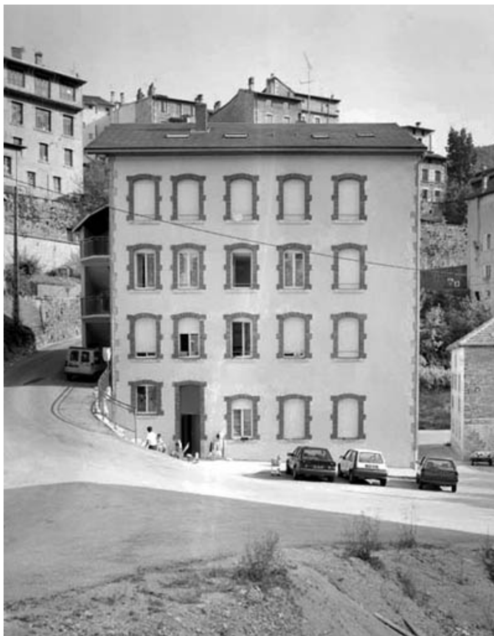
Immeuble (ancienne maison Vuillard) : façade antérieure.
