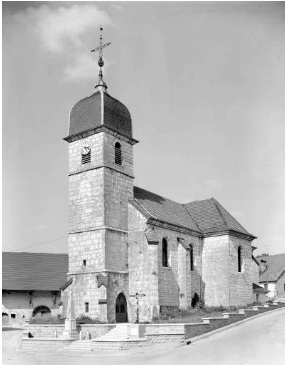
Facades antérieure et latérale droite.
