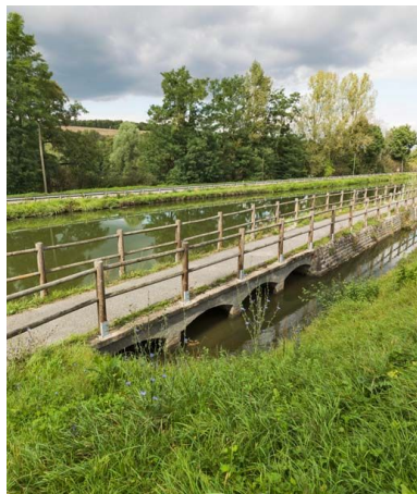
Vue du déversoir.
