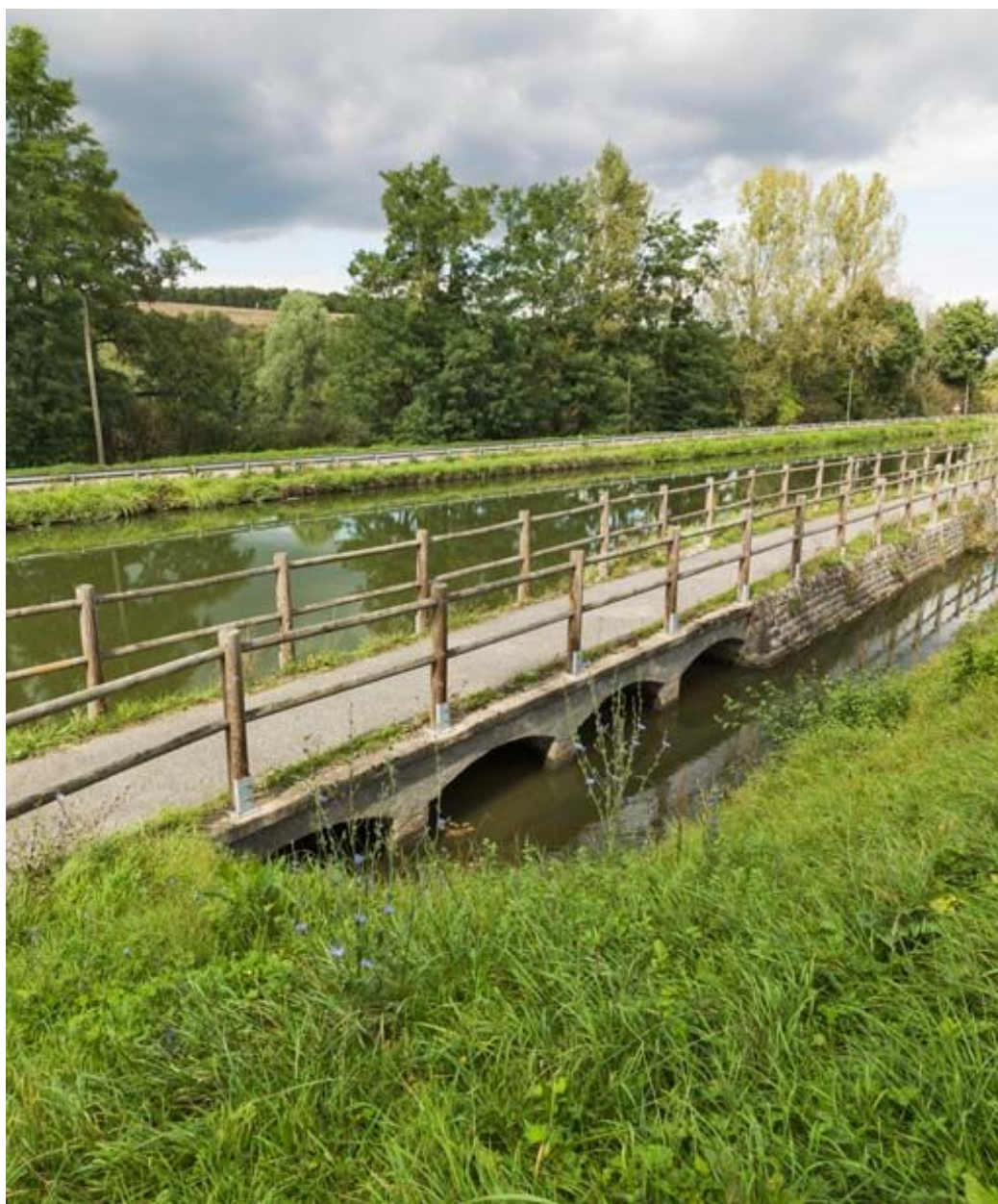
Vue du déversoir.
