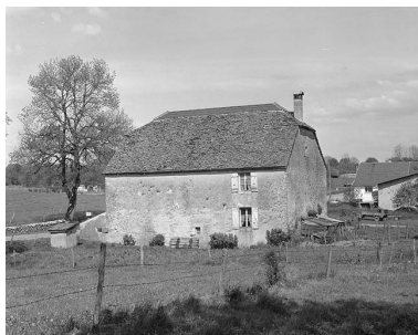
Ferme située à Granges de Ladoye : façades postérieure et latérale gauche. Phot. Yves Sancey IVR43_19813900131X
