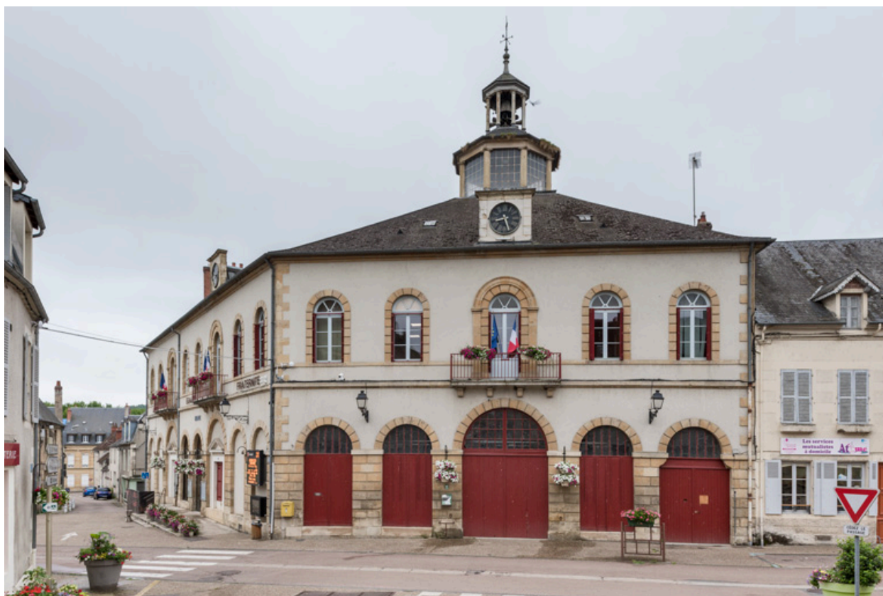
Façade latérale droite.
