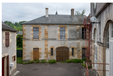
Ancienne remise. Phot. Pierre-Marie Barbe-Richaud IVR26_20245800344NUC4A
