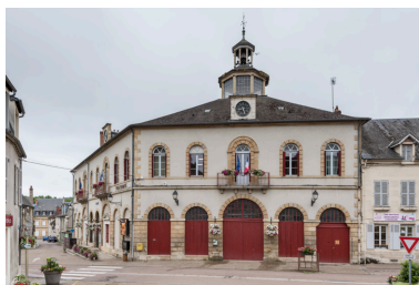
Façade latérale droite. Phot. Pierre-Marie Barbe-Richaud IVR26_20245800340NUC4A
