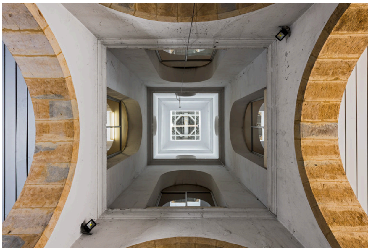
Rez-de-chaussée, halle : lanternon.
