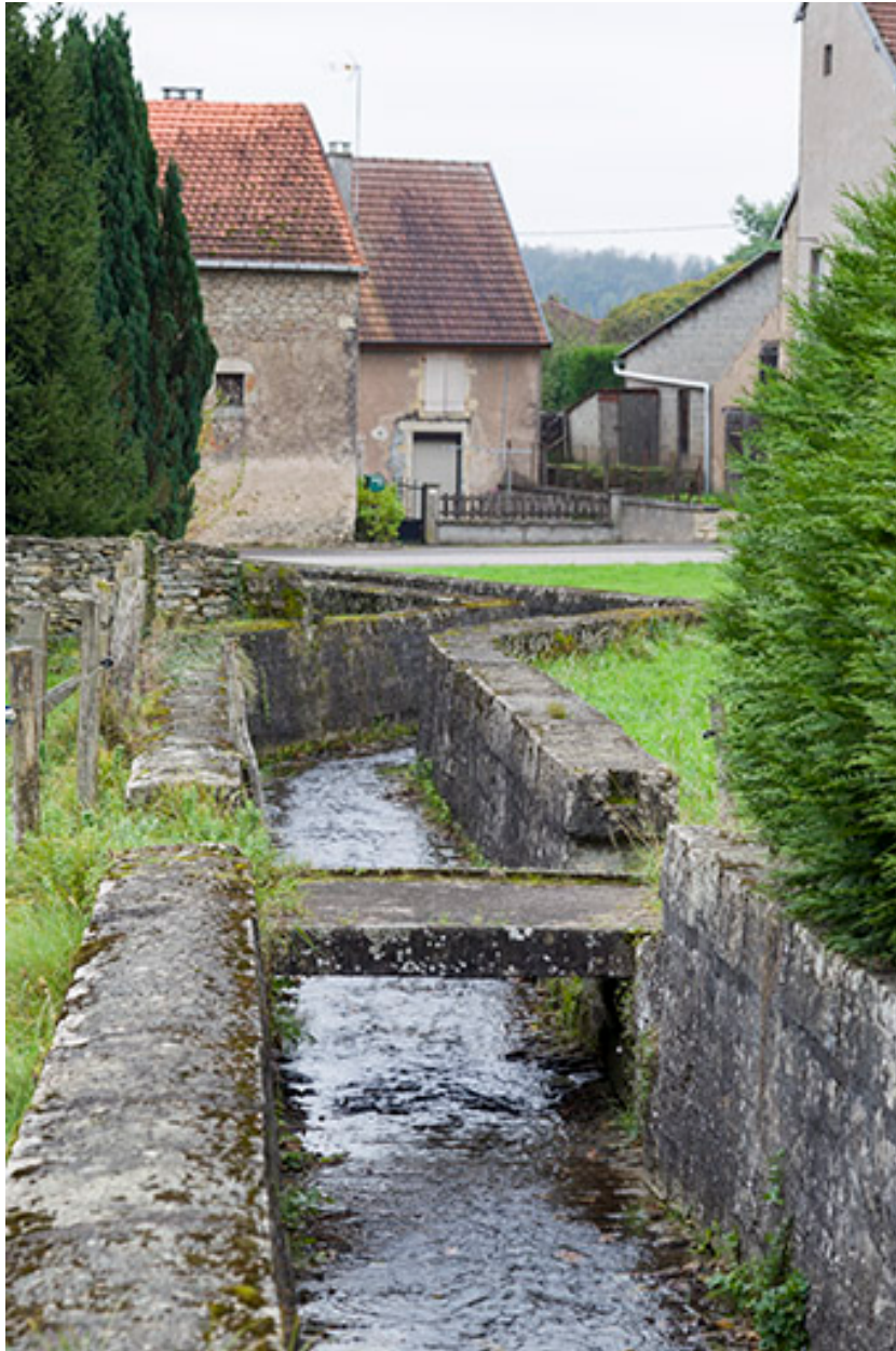
Le ruisseau canalisé traversant le village.
