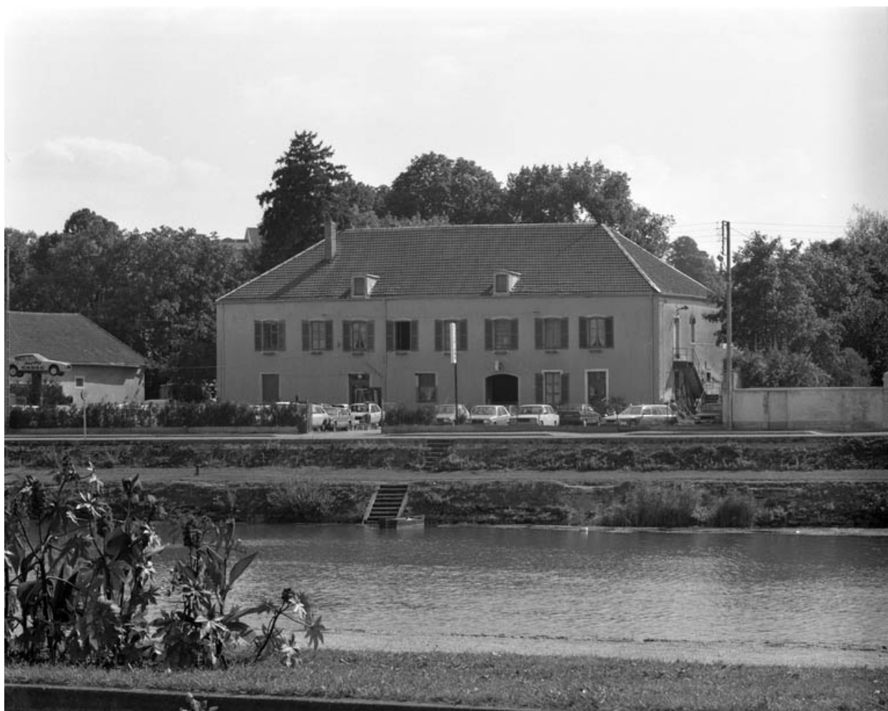
Le bâtiment principal depuis le quai Villeneuve.
