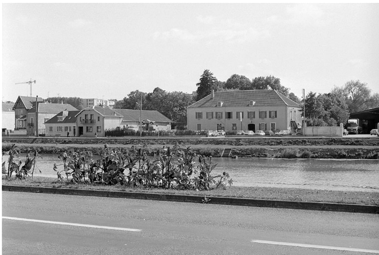
Vue d'ensemble depuis le quai Villeneuve.
