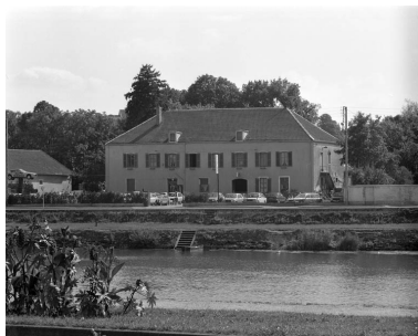
Le bâtiment principal depuis le quai Villeneuve. Phot. Yves Sancey IVR43_19887000175X
