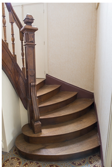
L'escalier conduisant aux chambres situées à l'étage. Phot. Mary Ruffinoni IVR43_20127000511NUC4A
