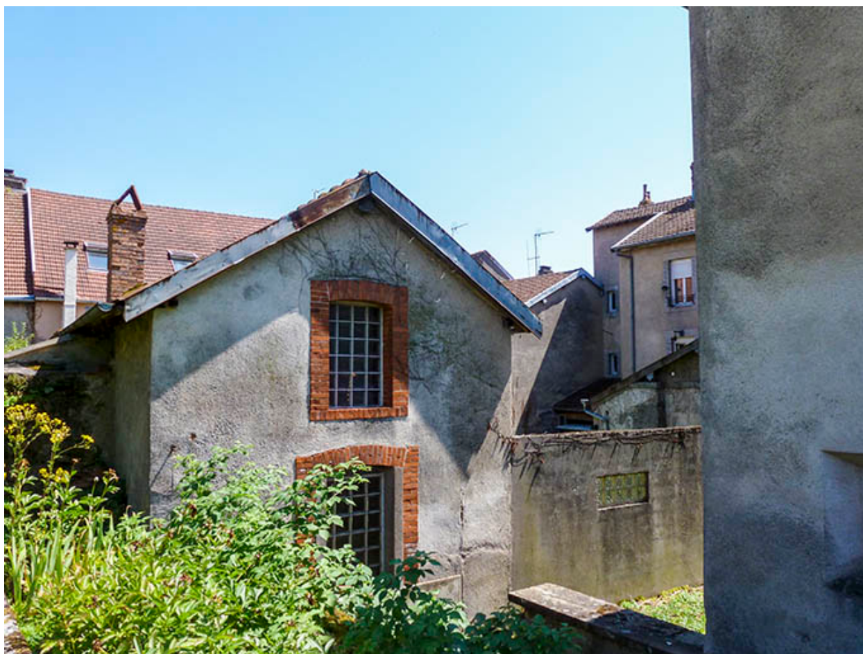
Vue générale de la remise.
