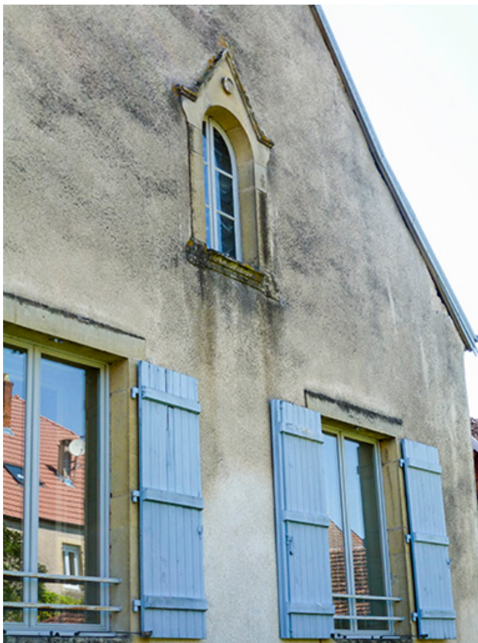
Façade postérieure : vue rapprochée.
