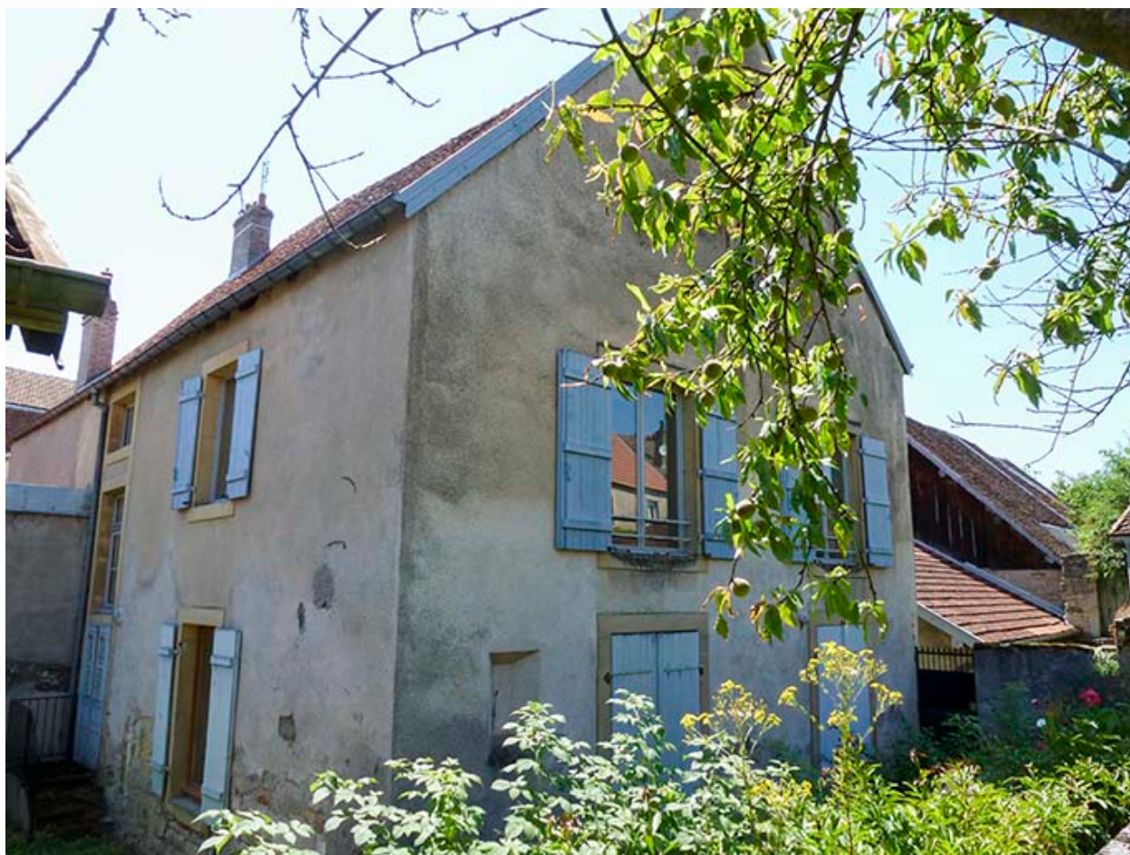
Façades postérieure et latérale droite.
