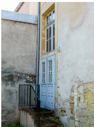
Façade latérale droite : porte de service. Phot. Jérôme Mongreville IVR43_20167000132NUC2A
