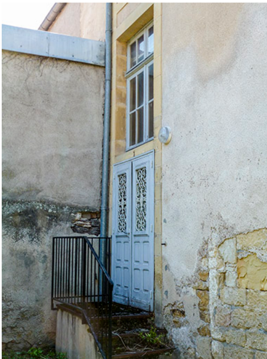
Façade latérale droite : porte de service.
