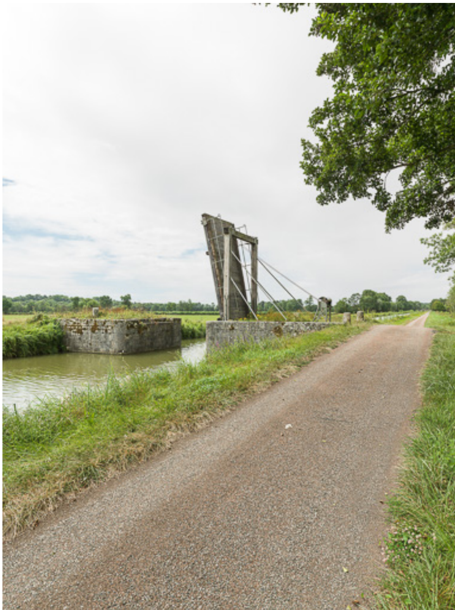
Vue d'ensemble du pont mobile, relevé.
