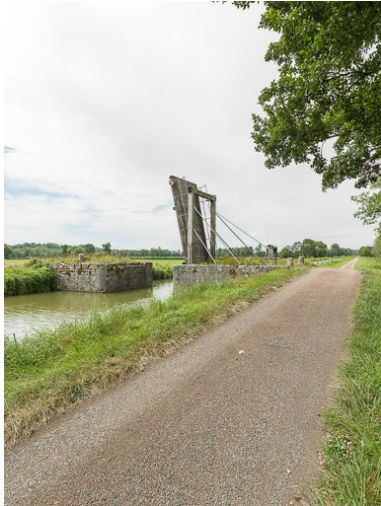
Vue d'ensemble du pont mobile, relevé.
