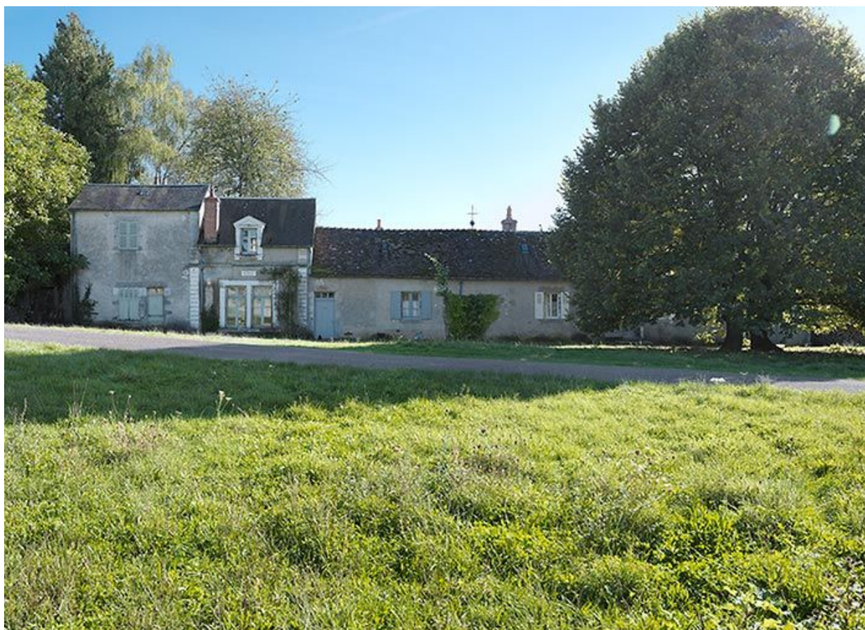
Vue d'ensemble des bâtiments, de face.
