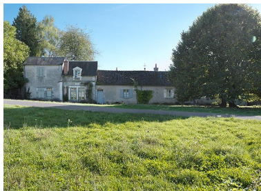
Vue d'ensemble des bâtiments, de face.
