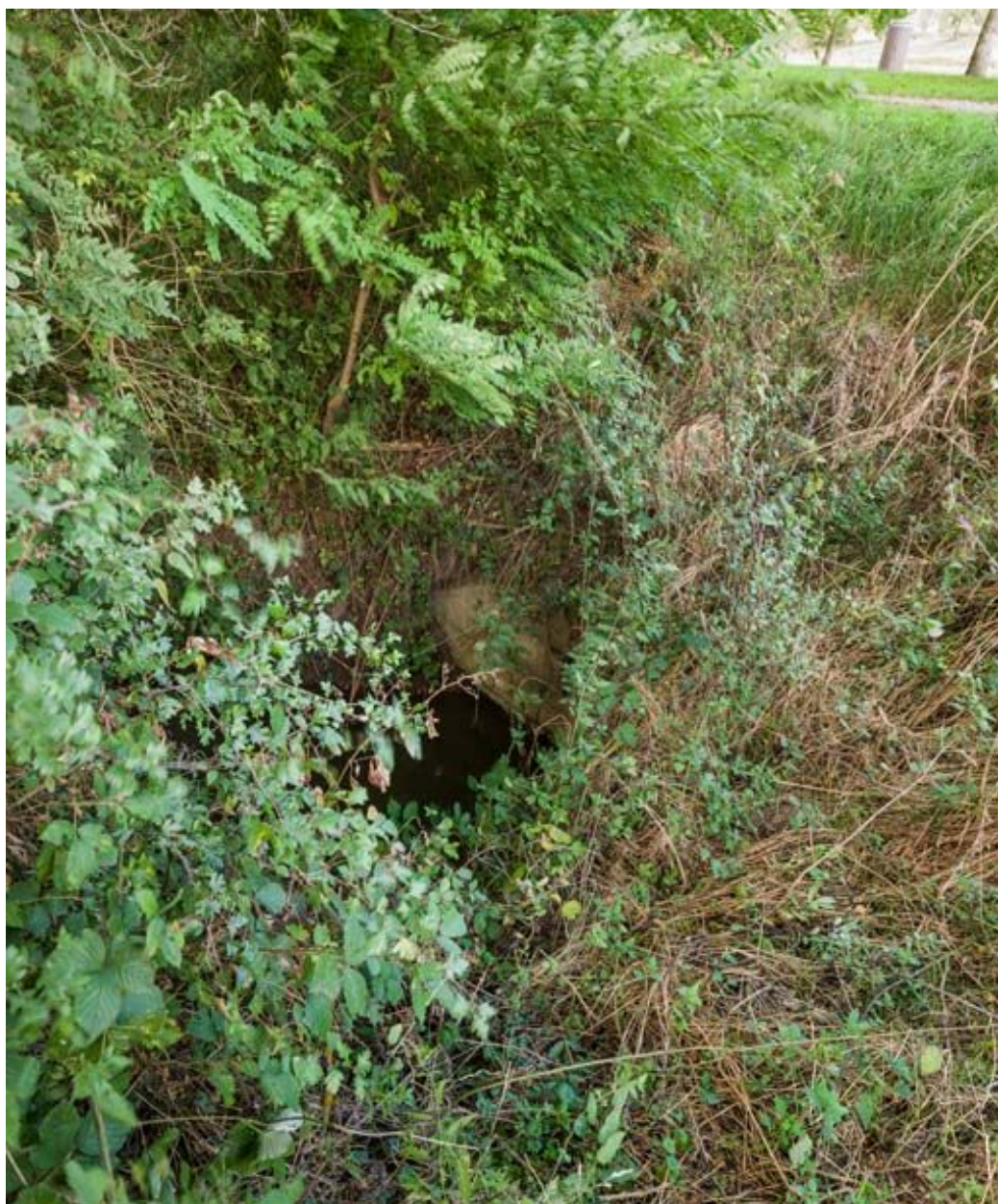
Vue de l'aqueduc.
