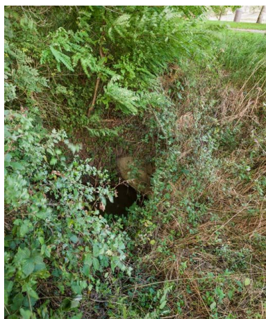
Vue de l'aqueduc.
