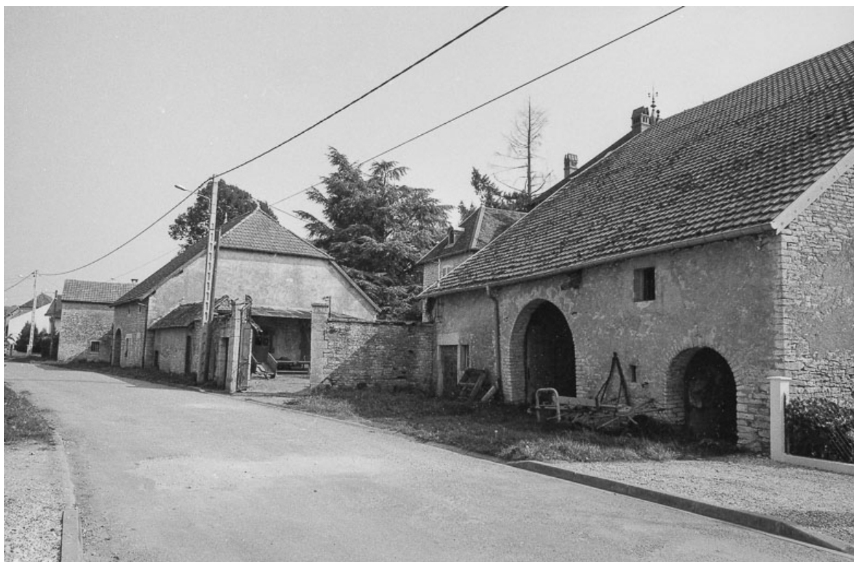
Ferme située chemin rural du Pré Simon.
