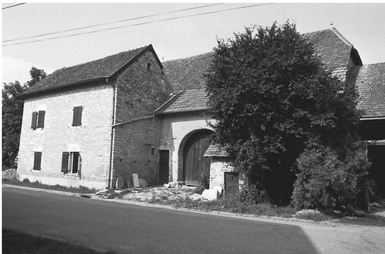
Ferme située chemin rural du Pré Simon.
