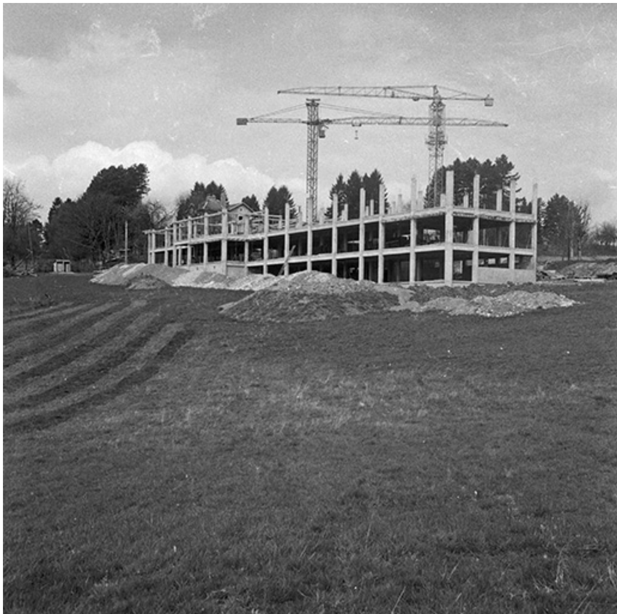
Travaux chantier du CETEHOR. Mars 1960.
