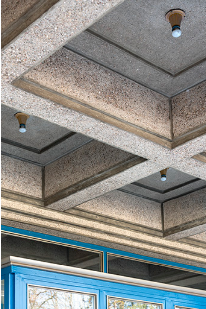
Façade antérieure, corps central : caissons du plafond de l'entrée.
