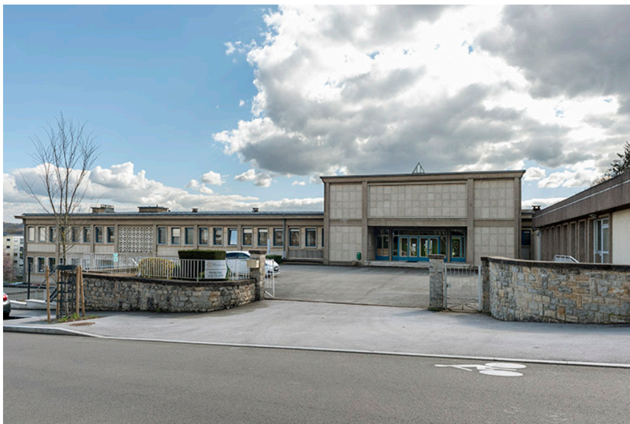
Façade antérieure et entrée.
