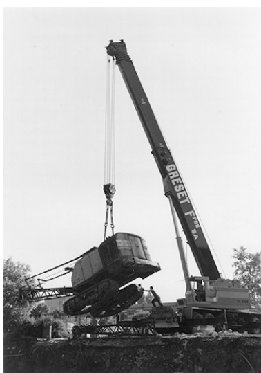
[Construction du laboratoire de métrologie, fondations : sortie à l'aide d'une grue de la sonnette utilisée pour le battage des pieux], 1981. IVR43_20192500521NUC2A
