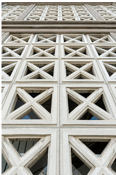
Façade antérieure, corps oriental : claustra, vue en contre-plongée. Phot. Sonia Dourlot IVR43_20192500199NUC4A
