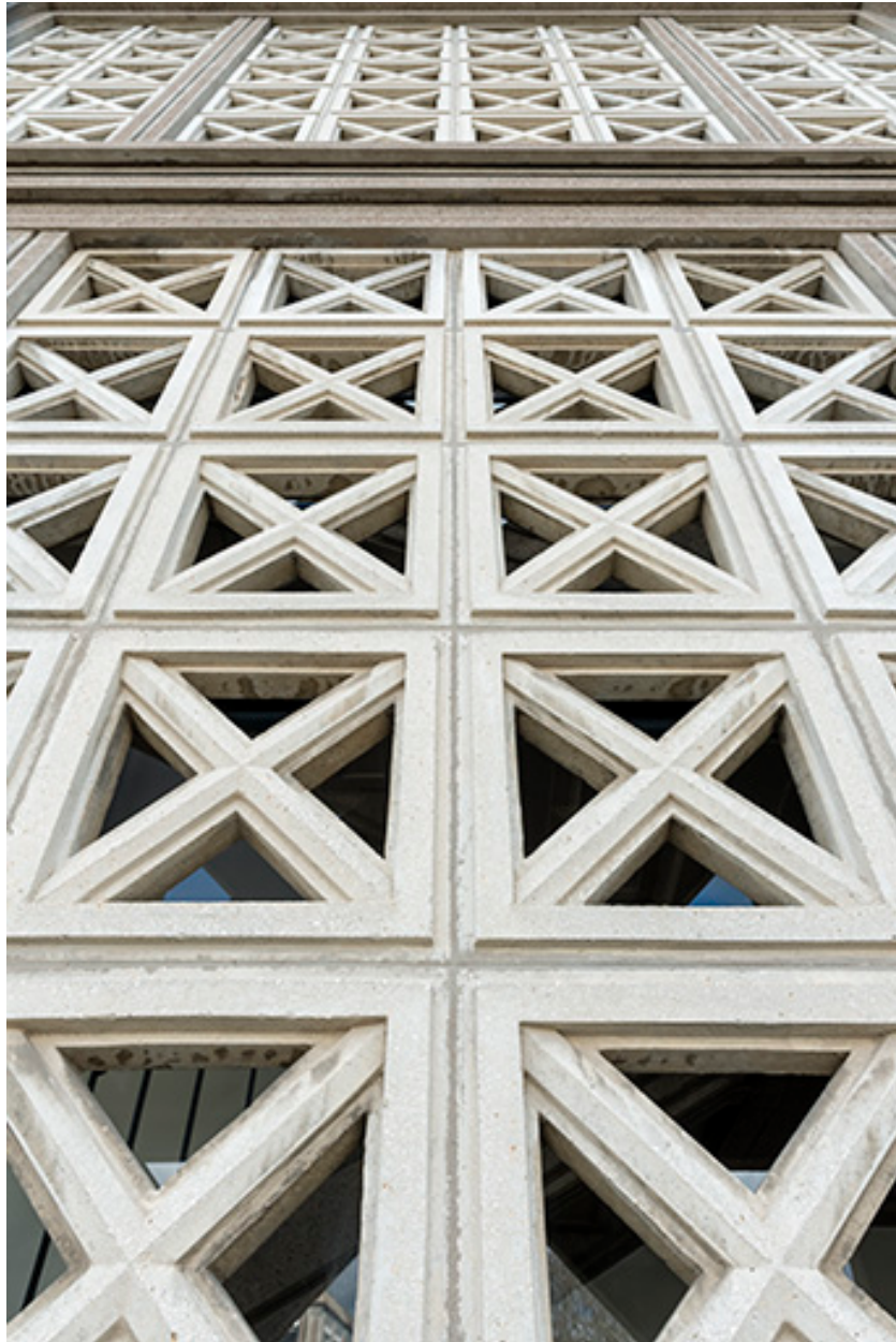
Façade antérieure, corps oriental : claustra, vue en contre-plongée.
