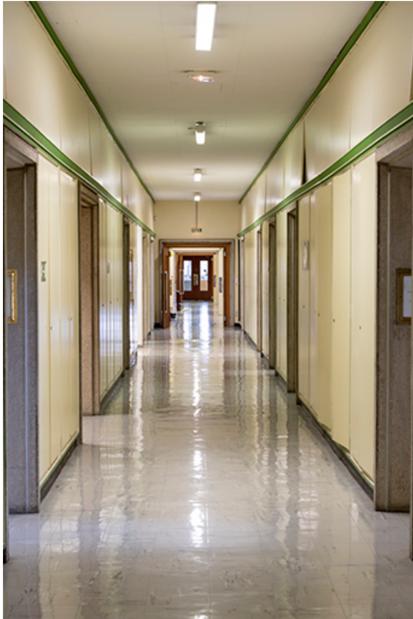
1er étage de soubassement : couloir.
