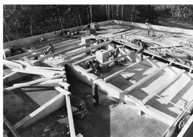
[Construction du laboratoire de métrologie : pose de la charpente], 1981. IVR43_20192500532NUC2A
