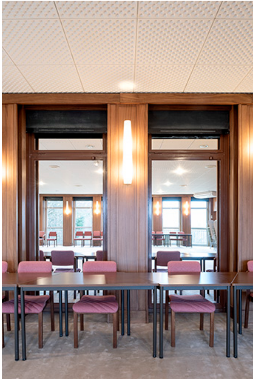
Rez-de-chaussée, corps occidental : miroir fermant certaines fenêtres de la salle de conférences.
