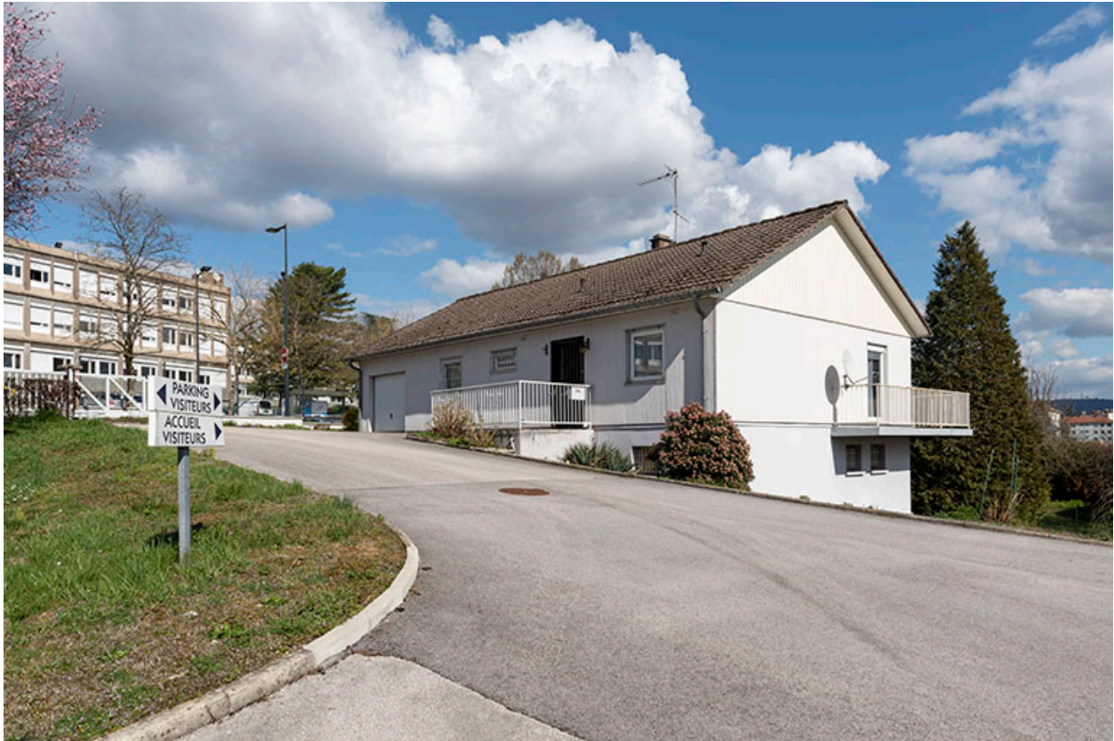
Conciergerie, depuis le sud-ouest.
