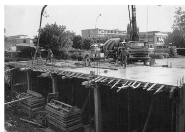
[Construction du laboratoire de métrologie, rez-de-chaussée : coulage du plancher en béton], 1981. IVR43_20192500525NUC2A
