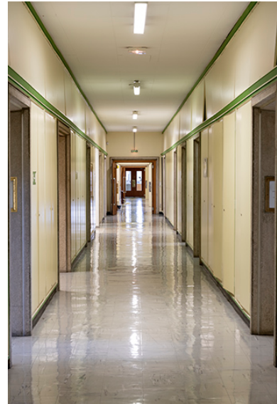
1er étage de soubassement : couloir. Phot. Sonia Dourlot IVR43_20192500248NUC4A
