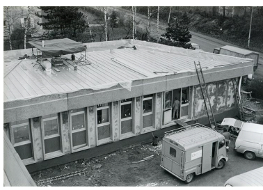
[Construction du laboratoire de métrologie : achèvement de la toiture], 1981. IVR43_20192500533NUC2A
