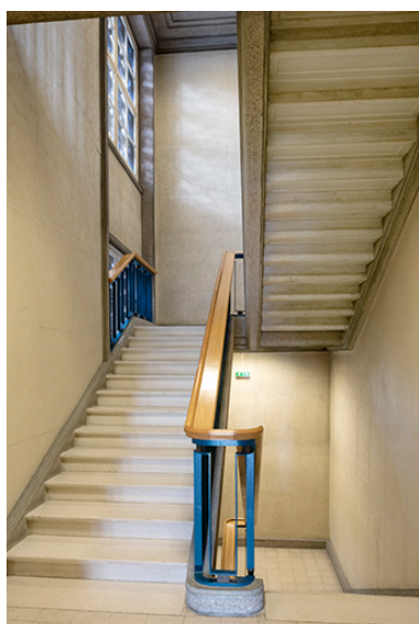
Rez-de-chaussée, corps central : escalier. Phot. Sonia Dourlot IVR43_20192500244NUC4A
