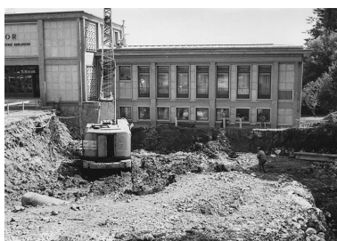
[Construction du laboratoire de métrologie, fondations : battage des pieux], 1981. IVR43_20192500518NUC2A
