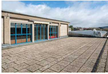
1er étage, corps central : terrasse et cantine. Phot. Sonia Dourlot IVR43_20192500239NUC4A
