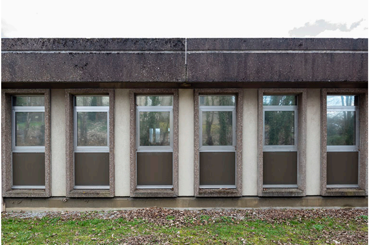
Ancien laboratoire de métrologie : fenêtres.
