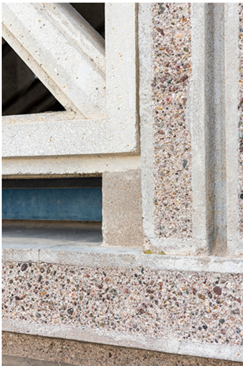
Façade antérieure, corps oriental : détail de la claustra.
