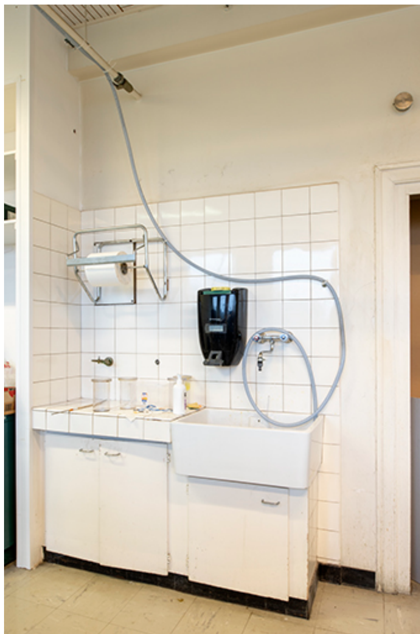
2e étage de soubassement, atelier de mécanique : paillasse ancienne.
