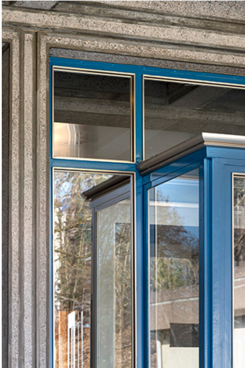
Façade antérieure, corps central : détail de l'entrée.
