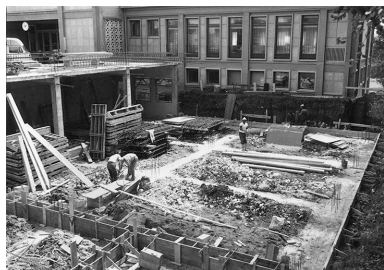
[Construction du laboratoire de métrologie, soubassement : fondations de la partie occidentale], 1981. IVR43_20192500526NUC2A
