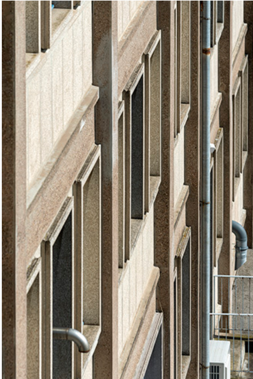
Façade postérieure, corps oriental : baies, vues en plongée et en enfilade.
