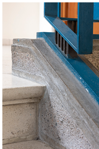
Rez-de-chaussée, corps oriental : détail de la rampe de l'escalier. Phot. Sonia Dourlot IVR43_20192500268NUC4A
