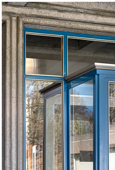
Façade antérieure, corps central : détail de l'entrée.
