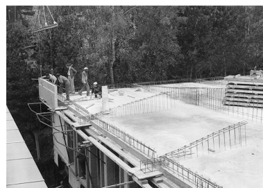
[Construction du laboratoire de métrologie : préparation des supports du toit], 1981. IVR43_20192500531NUC2A
