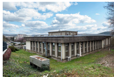
Ancien laboratoire de métrologie, depuis le nord-ouest. Phot. Sonia Dourlot IVR43_20192500202NUC4A
