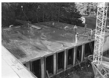
[Construction du laboratoire de métrologie : préparation des supports du toit], 1981. IVR43_20192500530NUC2A
