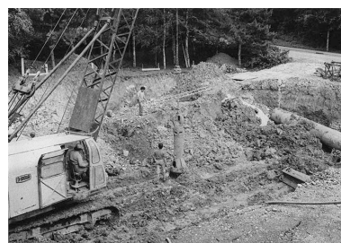
[Construction du laboratoire de métrologie, fondations : battage des pieux], 1981. IVR43_20192500519NUC2A
