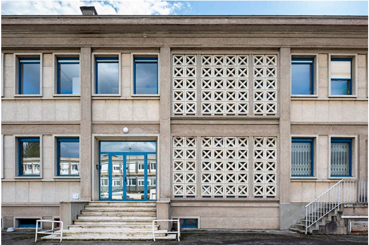
Façade antérieure, corps oriental : travées.
