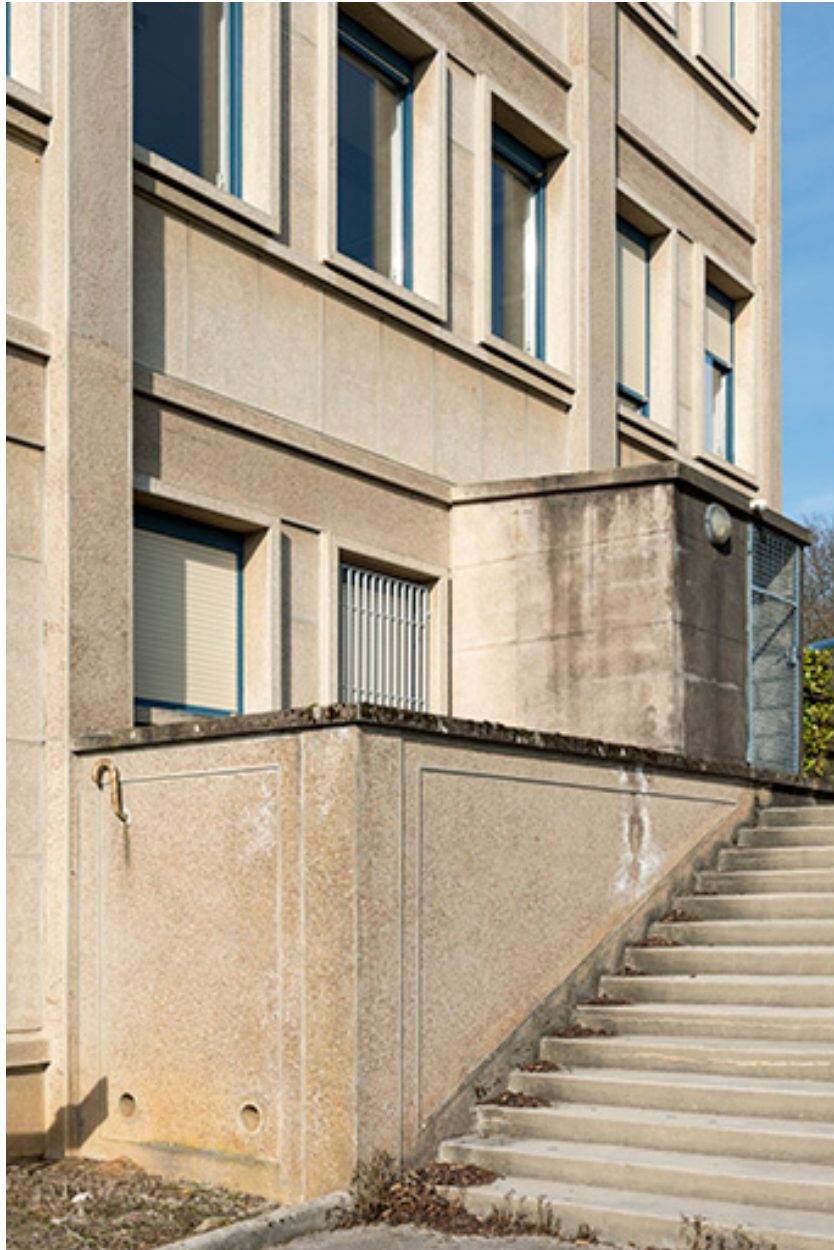
Façade latérale gauche (corps oriental) : escalier indépendant.
