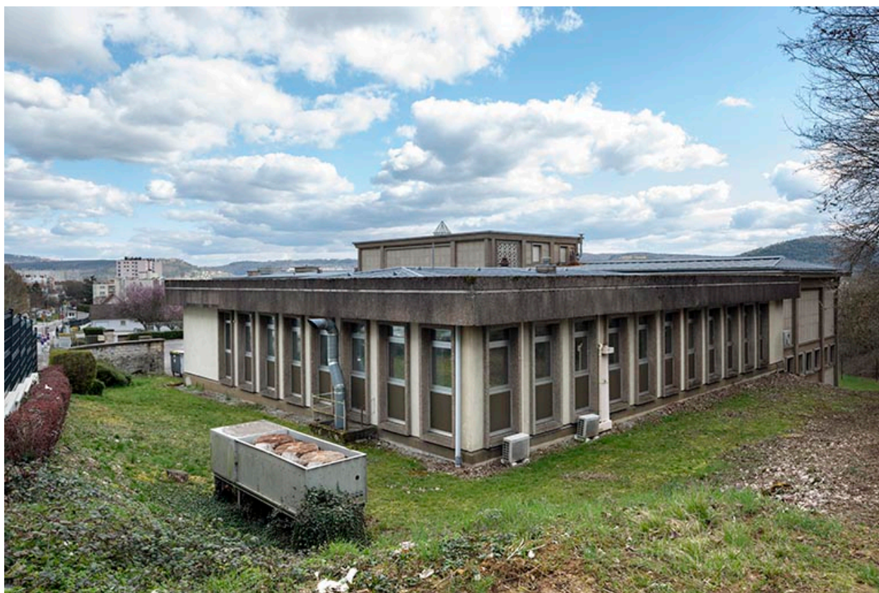
Ancien laboratoire de métrologie, depuis le nord-ouest.
