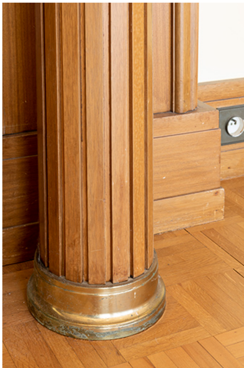
Rez-de-chaussée, corps central : habillage d'un poteau de la salle André Donat.
