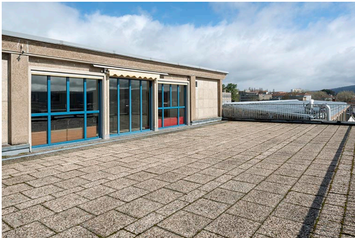
1er étage, corps central : terrasse et cantine.
