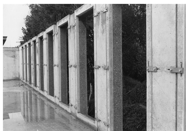
[Construction du laboratoire de métrologie, rez-de-chaussée : mur occidental], 1981. IVR43_20192500529NUC2A
