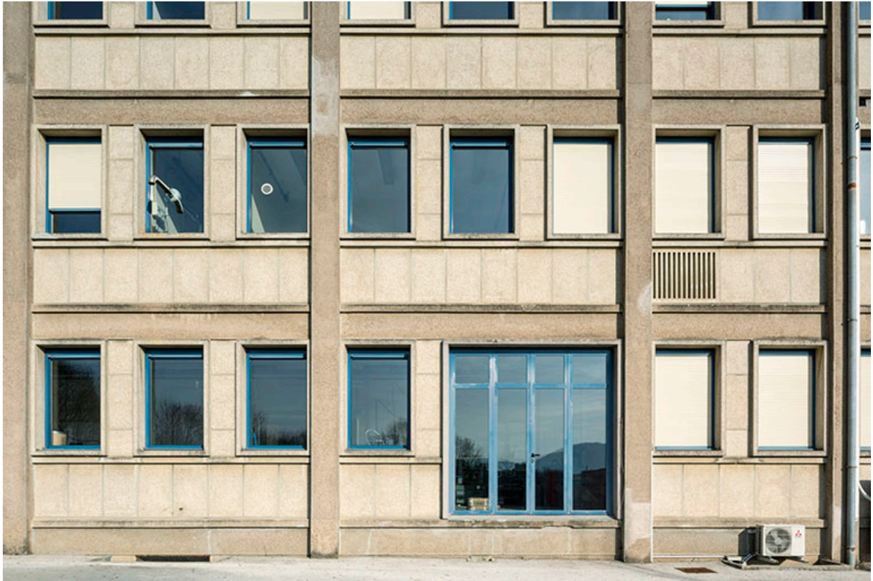
Façade postérieure, corps oriental : travées.
