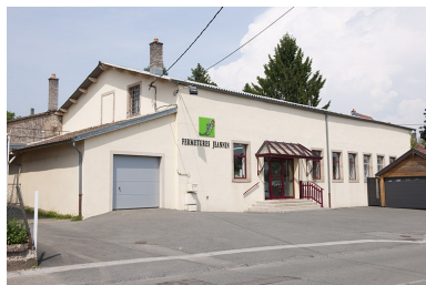
Atelier de fabrication (travail du bois). Phot. Jérôme Mongreville IVR43_20122501039NUC4A
