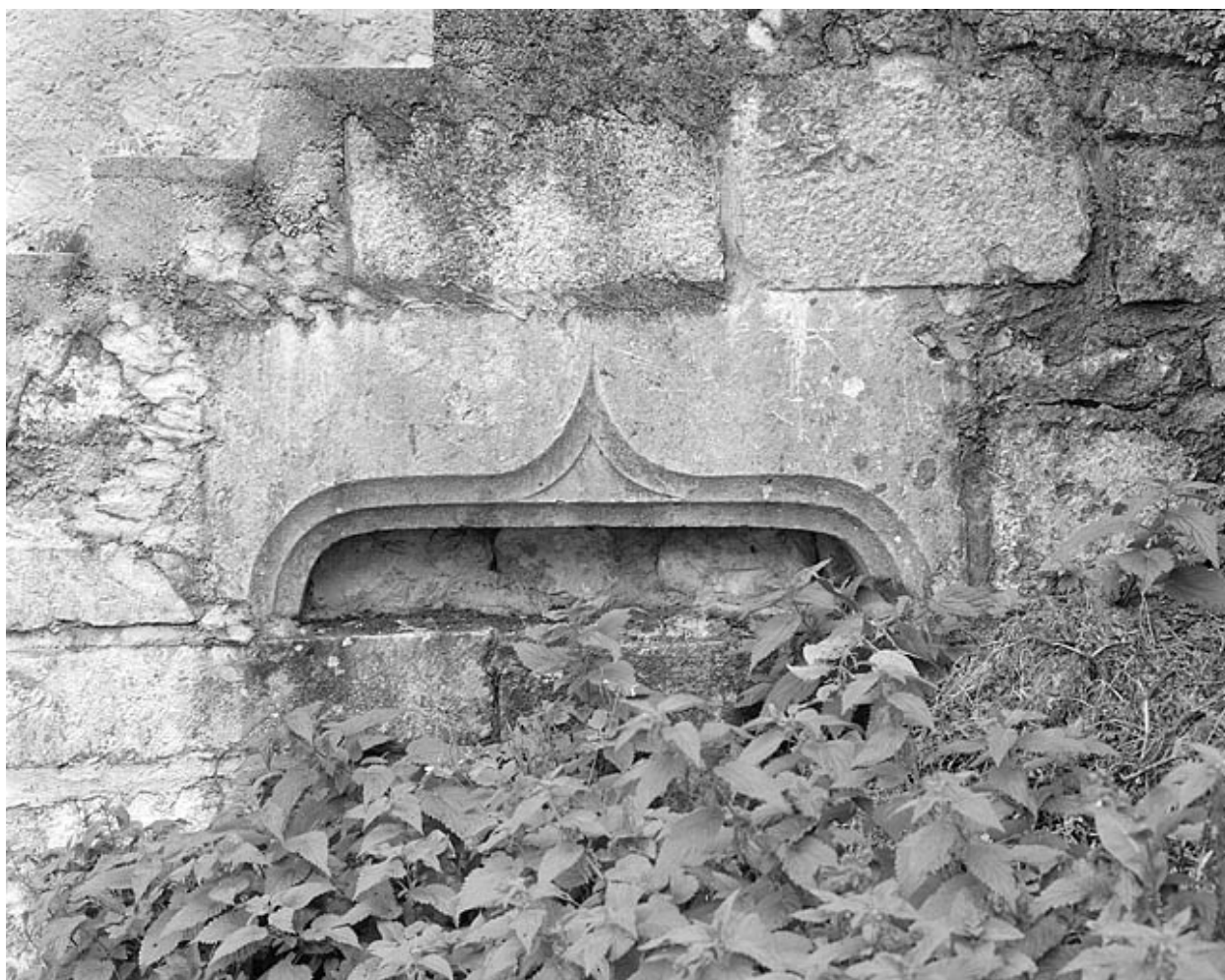
Linteau en accolade remployé.
