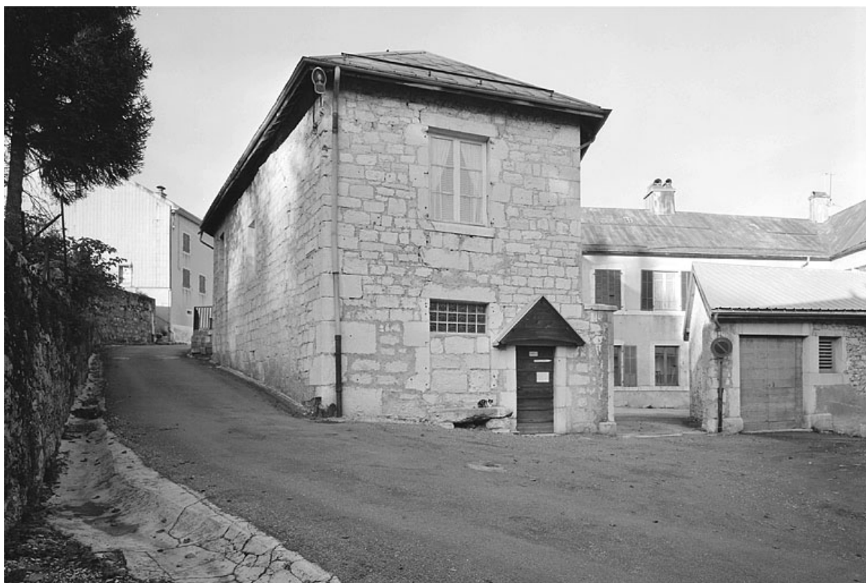
Vue générale, face sud-ouest.
