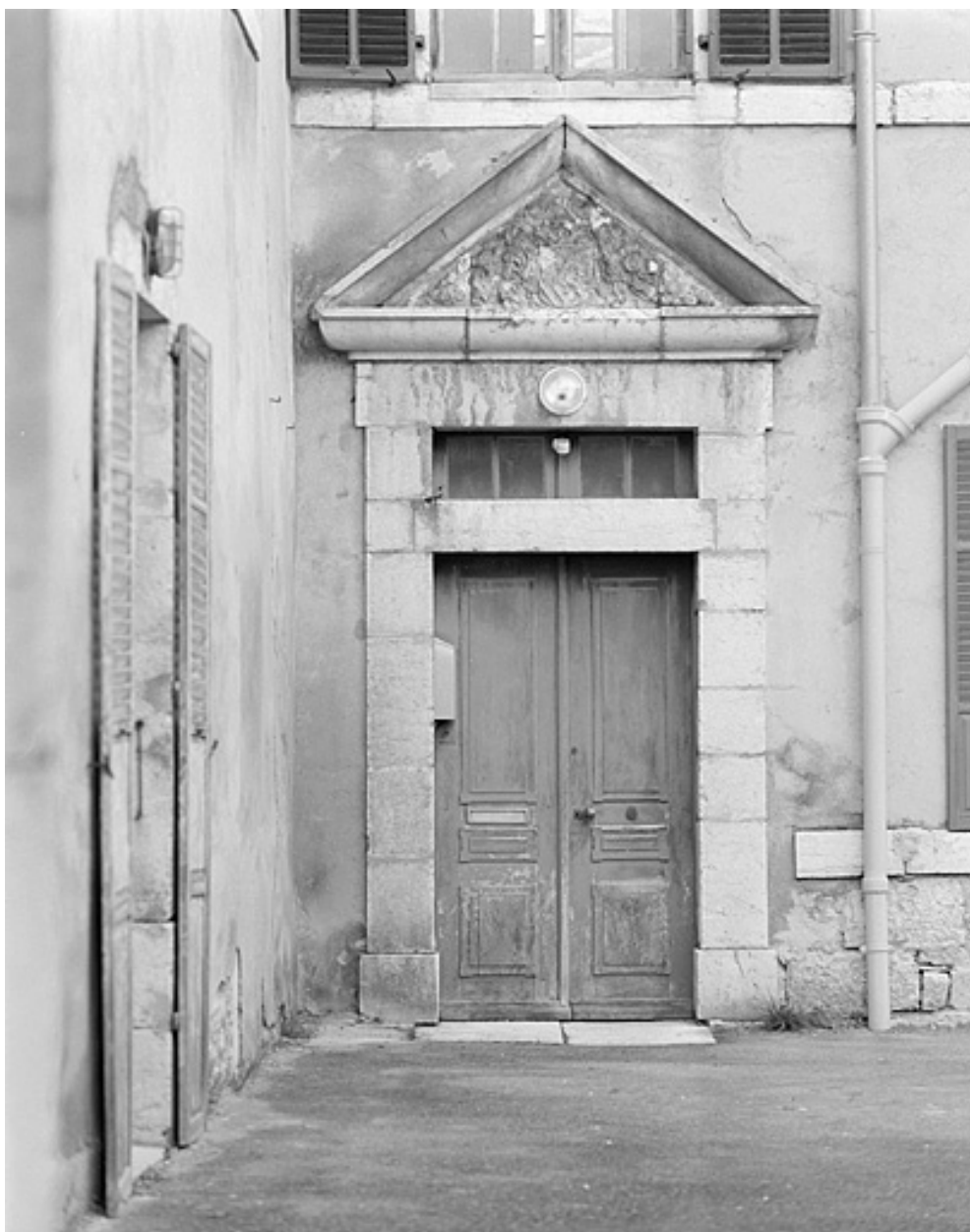
La porte d'entrée de l'ancien presbytère.
