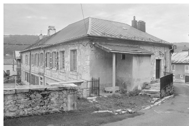
Façade postérieure et face ouest. Phot. Jérôme Mongreville IVR43_19963901303X
