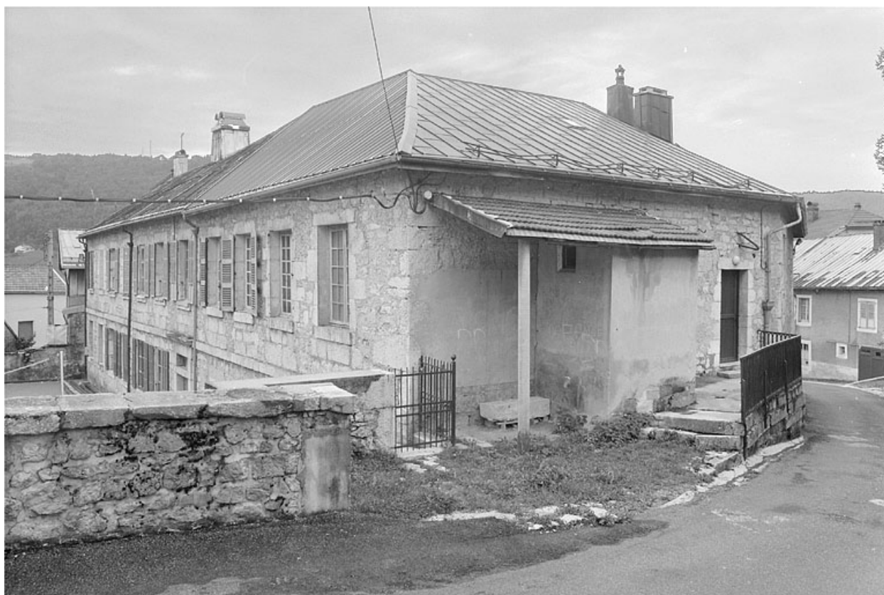
Façade postérieure et face ouest.
