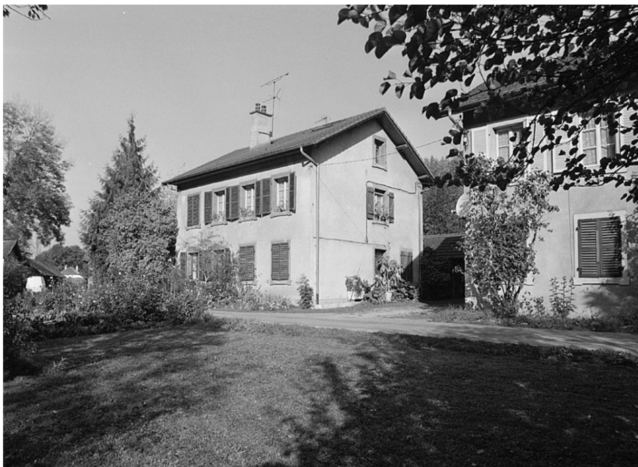
Logements depuis le sud-est.
