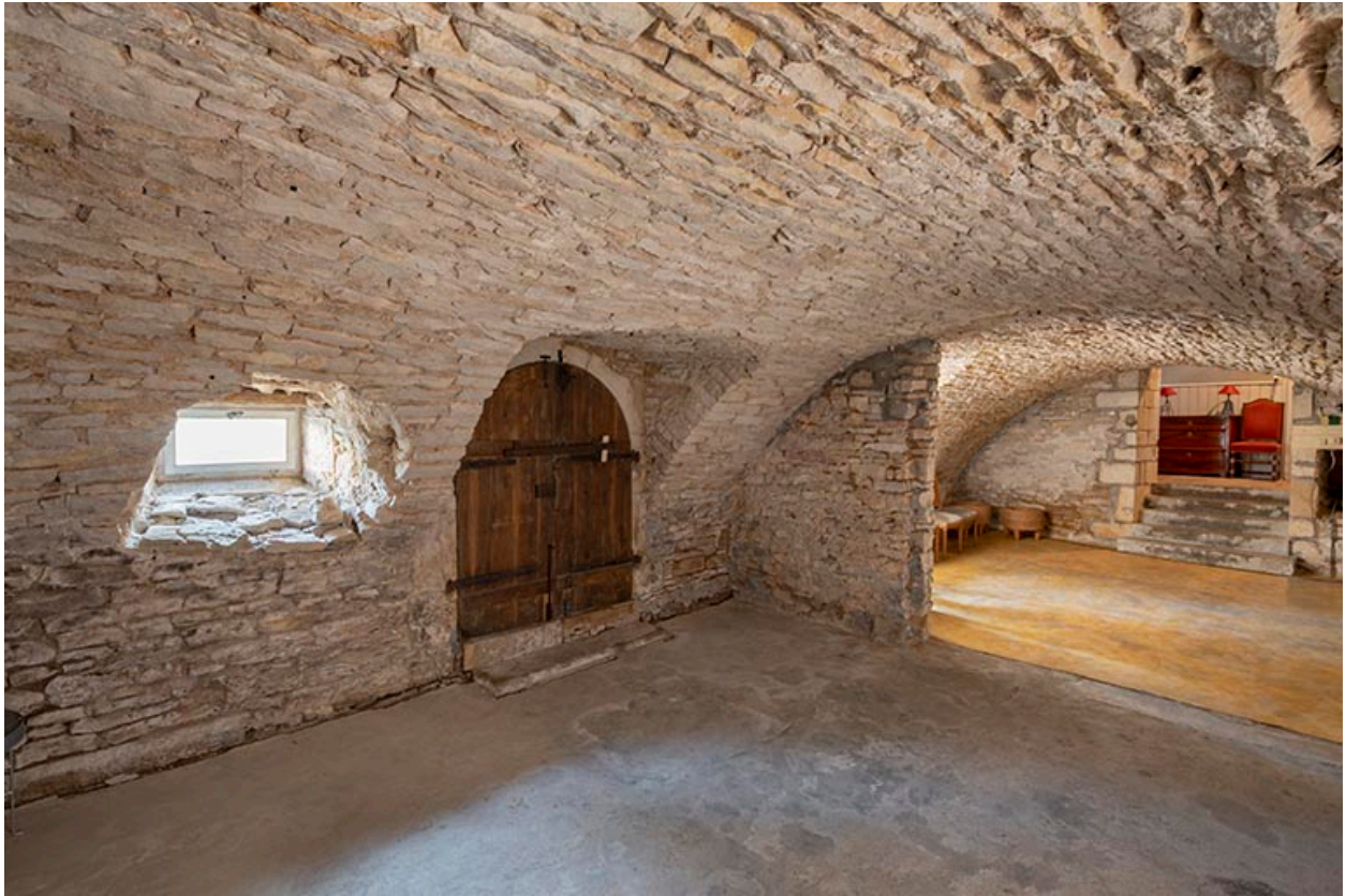
Cave de l'aile ouest, vue intérieure depuis le nord.
