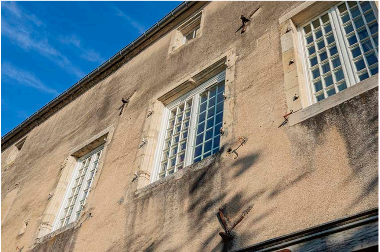
Baies de la façade sud du corps principal.
