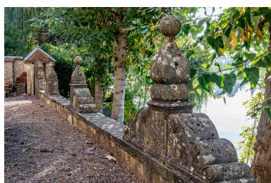
Terrasse donnant sur la Saône, garde-corps du mur de soutènement. Phot. Jérôme Mongreville IVR43_20187000703NUC4A
