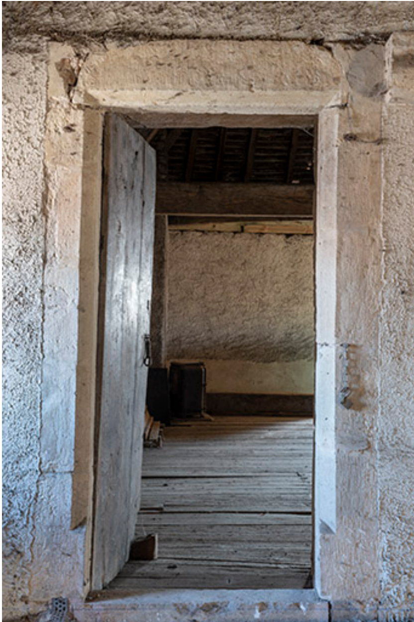
Comble du corps principal, porte séparant les deux parties constitutives (vue vers l'est).
