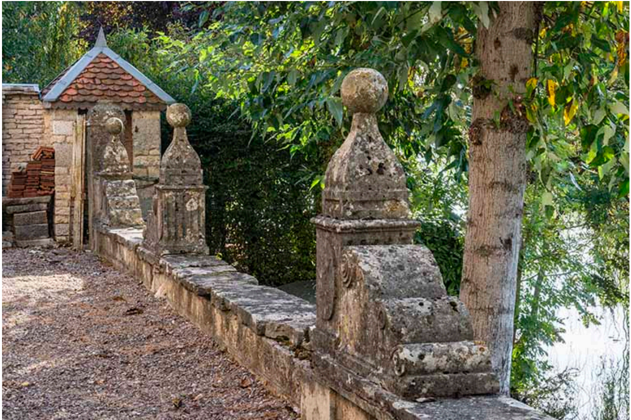
Terrasse donnant sur la Saône, garde-corps du mur de soutènement.
