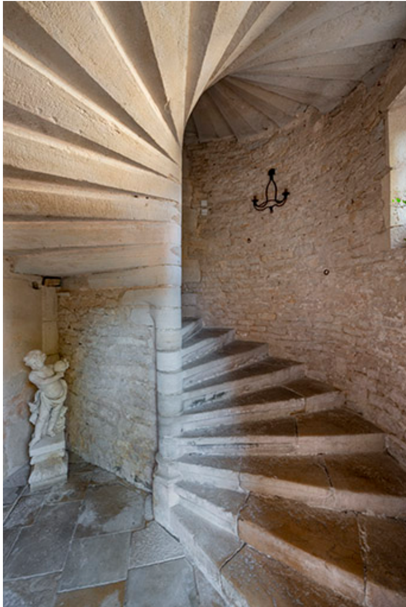
Escalier en vis, rez-de-chaussée.
