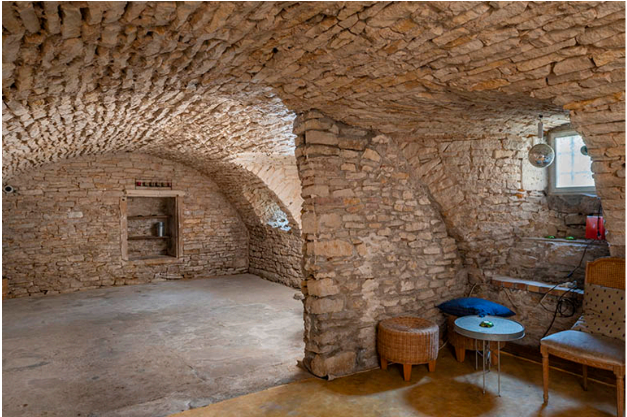
Cave de l'aile ouest, vue intérieure depuis le sud.
