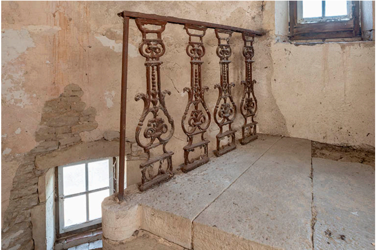
Escalier en vis, comble.
