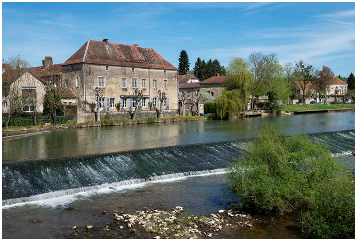
Vue d'ensemble depuis le pont sur la Saône.
