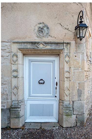
Encadrement de la porte de la tour d'escalier (porte fermée). Phot. Jérôme Mongreville IVR43_20187000696NUC4A
