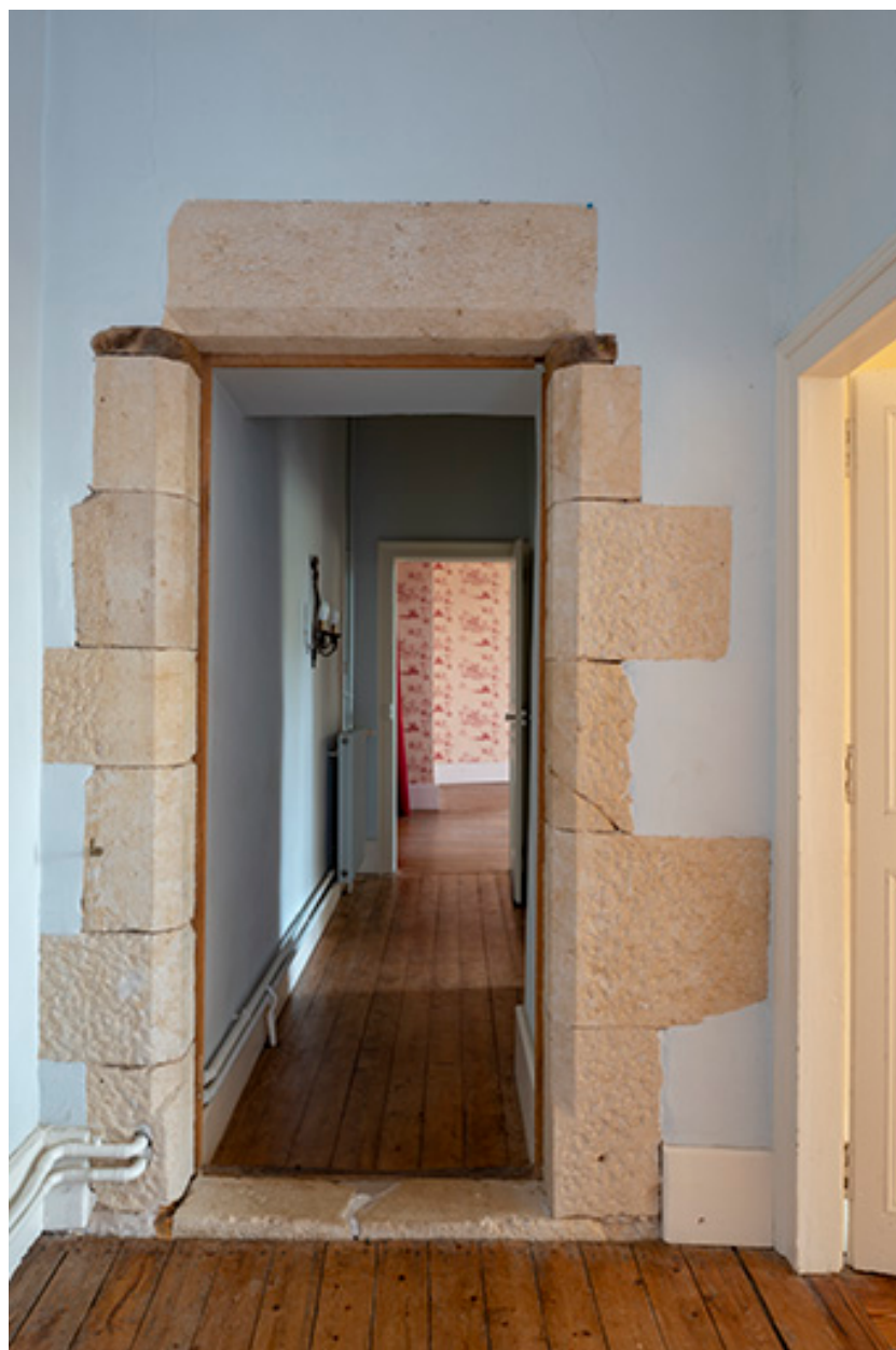
Premier étage du corps principal, porte séparant les deux parties constitutives (vue vers l'est).
