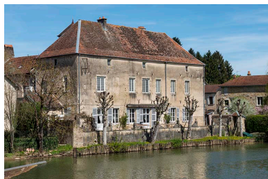
Façade sud du corps principal et terrasse donnant sur la Saône. Phot. Jérôme Mongreville IVR43_20187000690NUC4A
