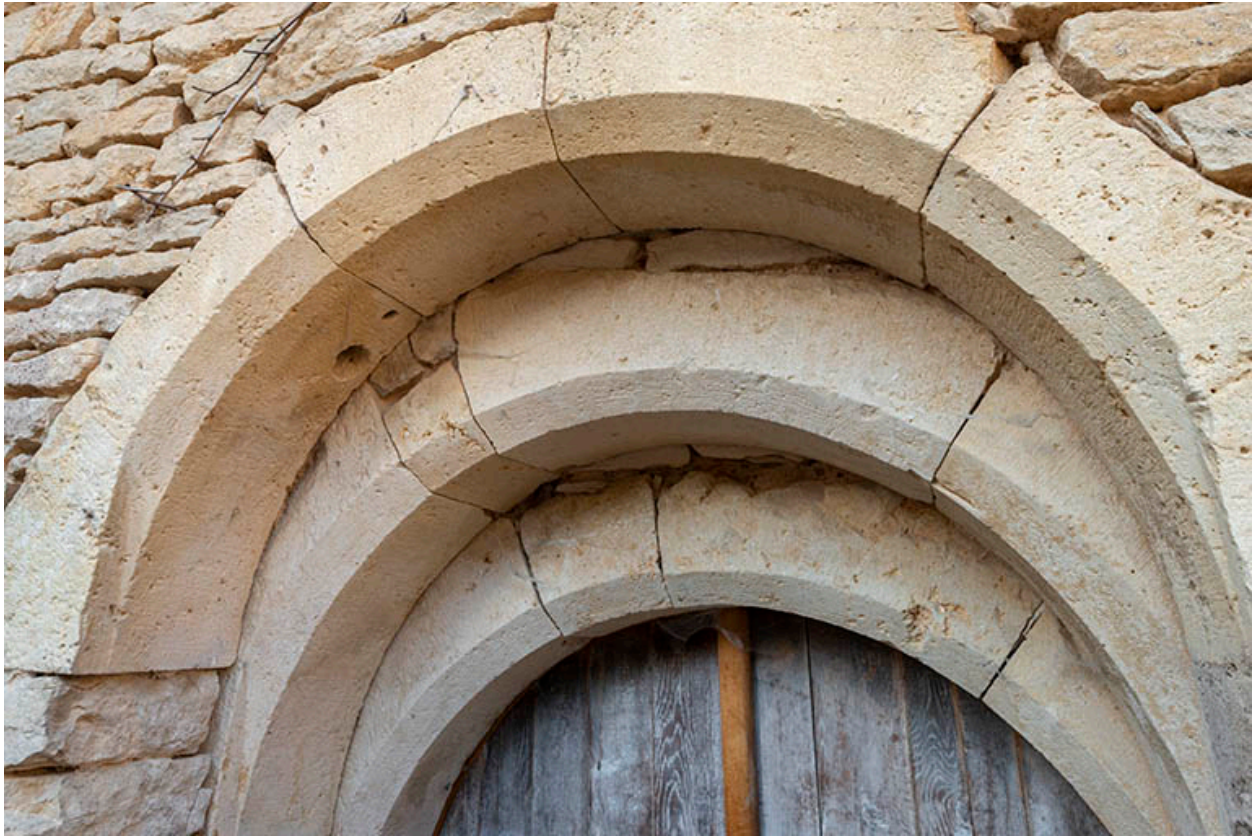
Porte de cave de l'aile ouest, détail de la voussure.
