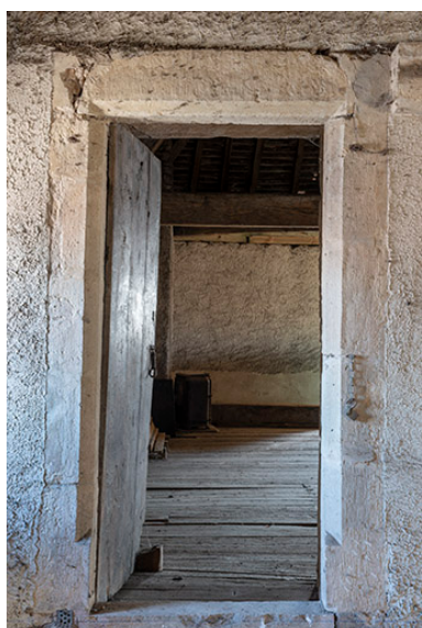
Comble du corps principal, porte séparant les deux parties constitutives (vue vers l'est). Phot. Jérôme Mongreville IVR43_20187000712NUC4A
