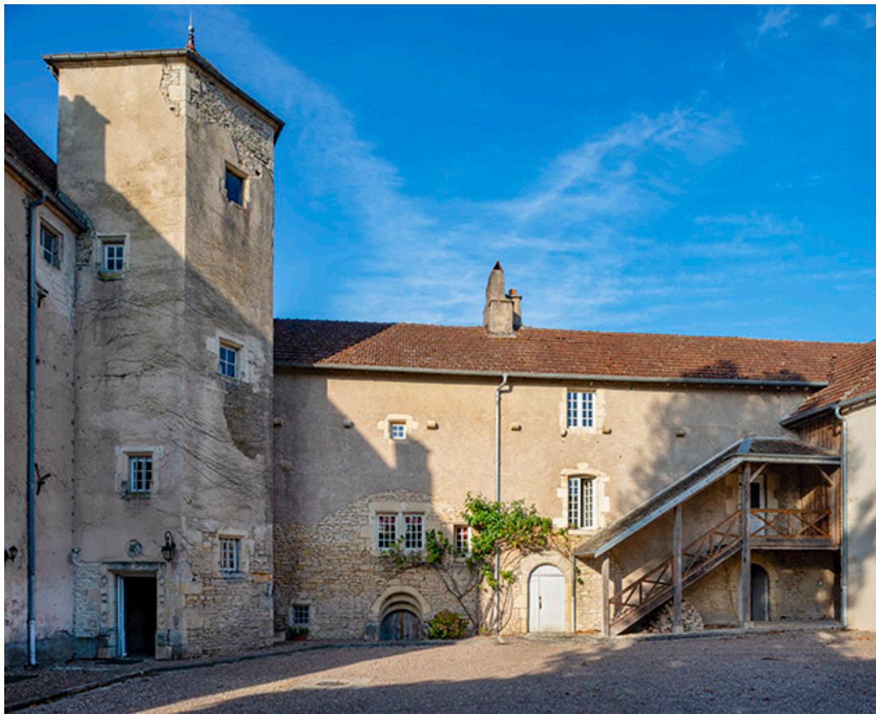
Façade est de l'aile latérale ouest, vue depuis l'est.
