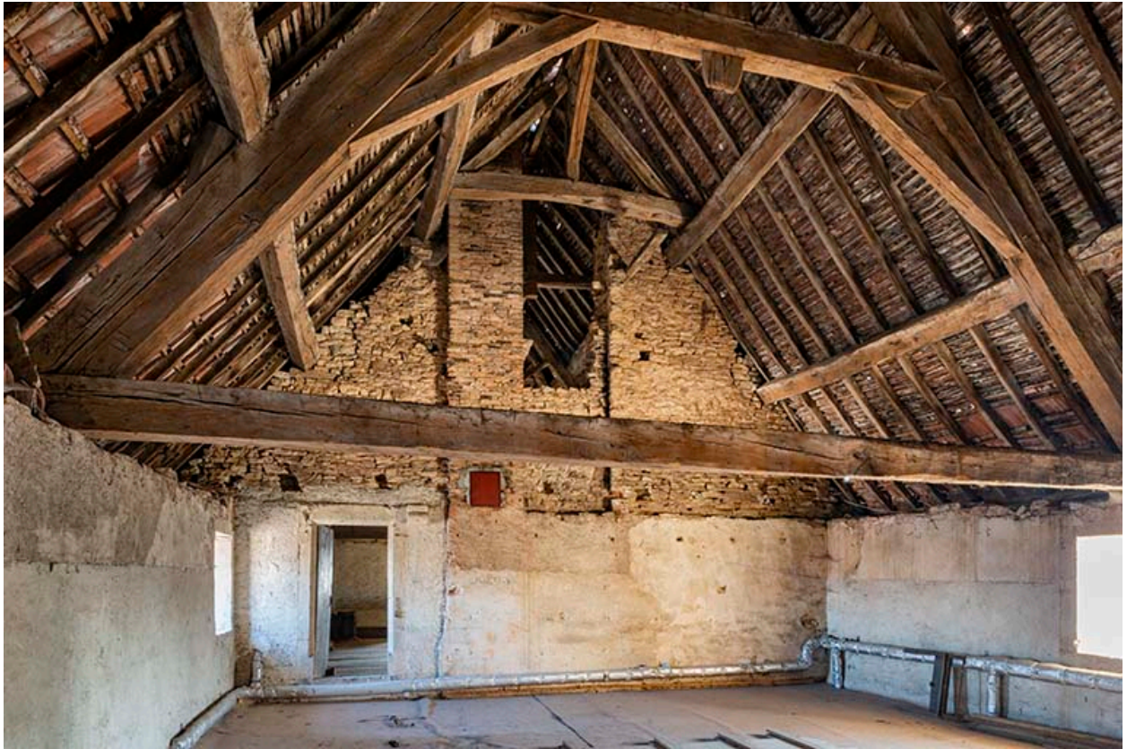
Comble du corps principal avec charpente en bois apparente, vue en direction de l'est.
