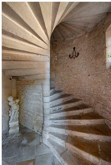
Escalier en vis, rez-de-chaussée. Phot. Jérôme Mongreville IVR43_20187000722NUC4A
