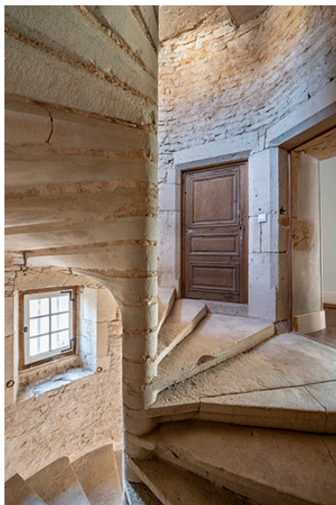
Escalier en vis, premier étage. Phot. Jérôme Mongreville IVR43_20187000717NUC4A
