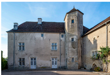
Façade nord du corps principal et cour, vue depuis le nord. Phot. Jérôme Mongreville IVR43_20187000693NUC4A
