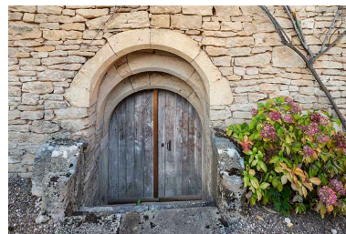
Porte de cave de l'aile ouest donnant sur la cour. Phot. Jérôme Mongreville IVR43_20187000697NUC4A
