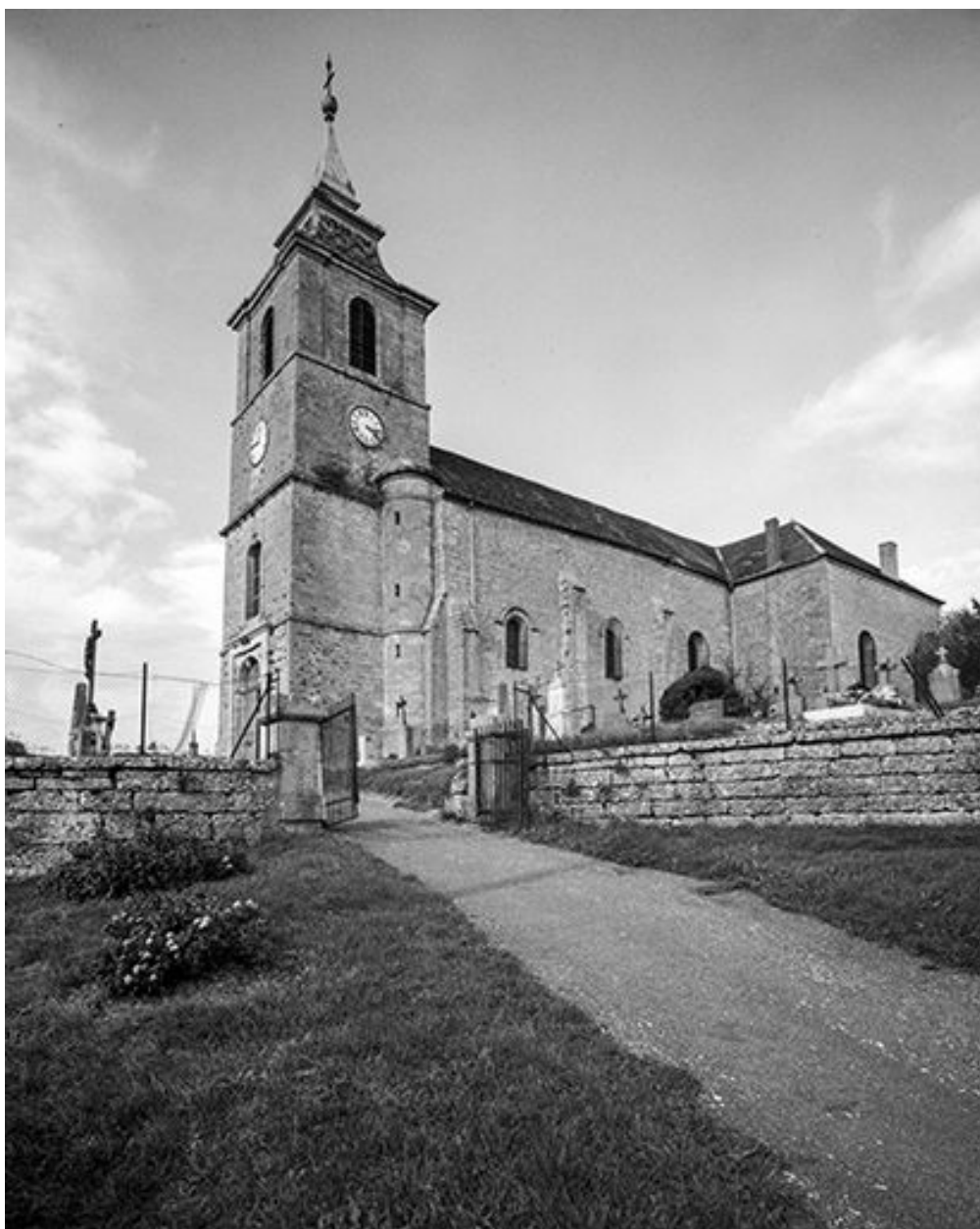
Tour-clocher et façade latérale droite.
