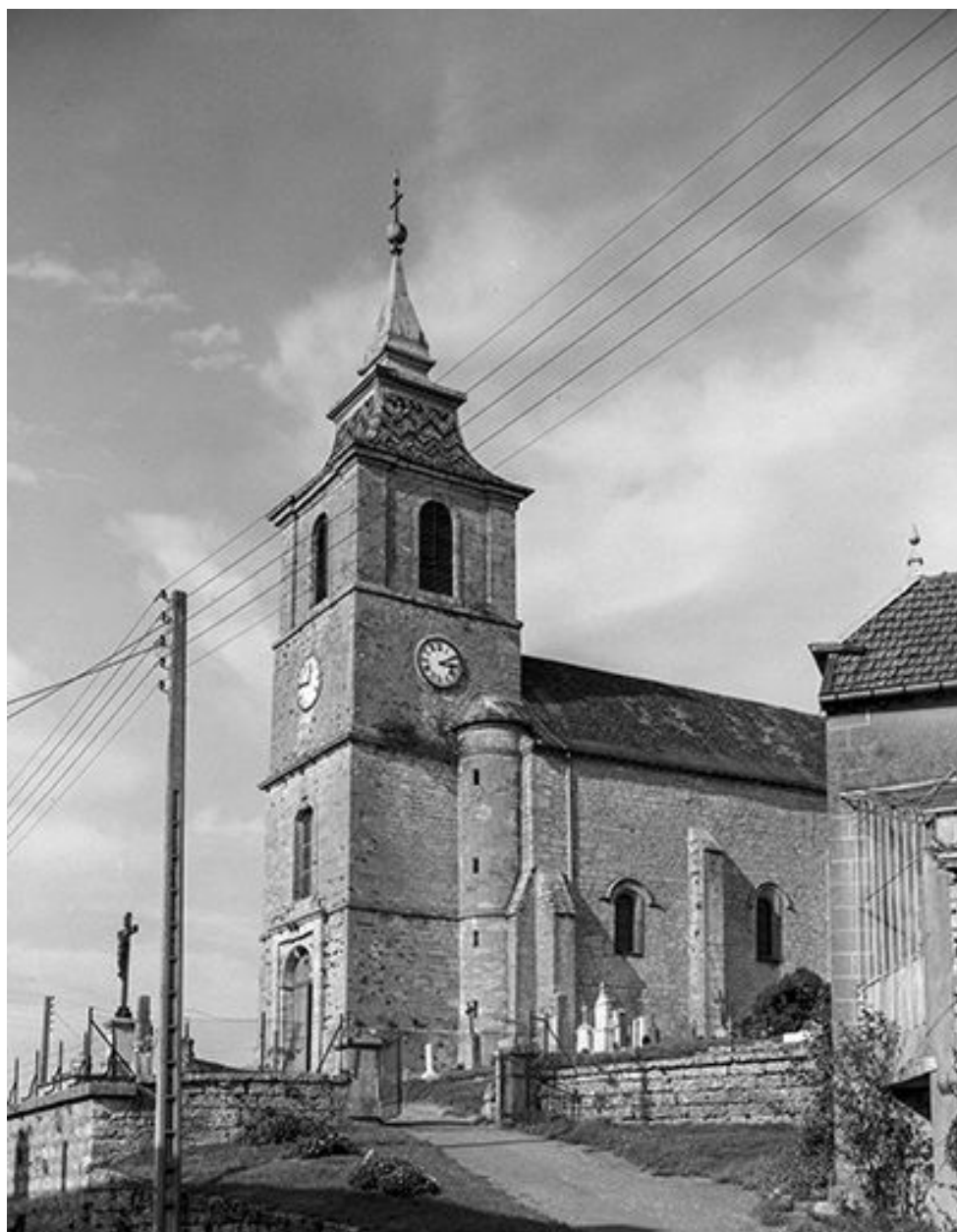
Tour-clocher et façade latérale droite.
