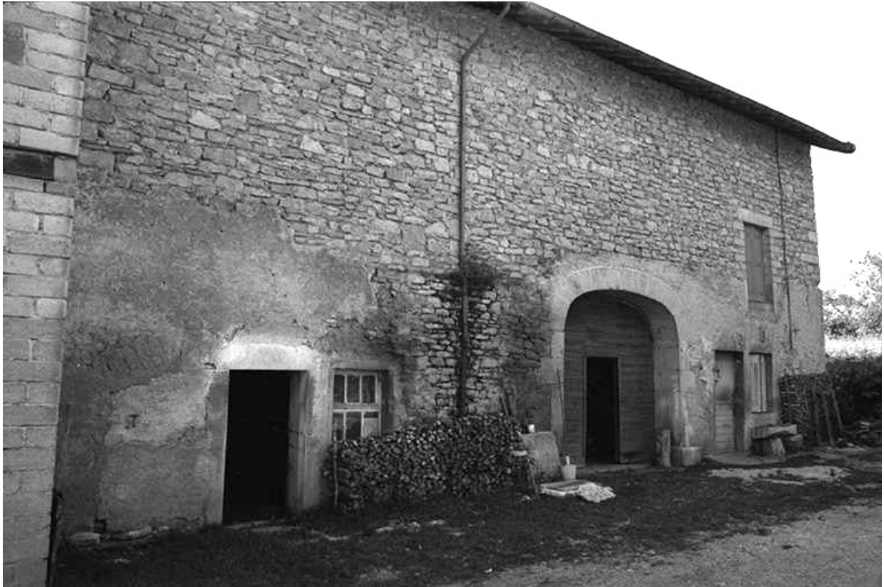
Ferme cadastrée 1957 A1 232 : façade antérieure.
