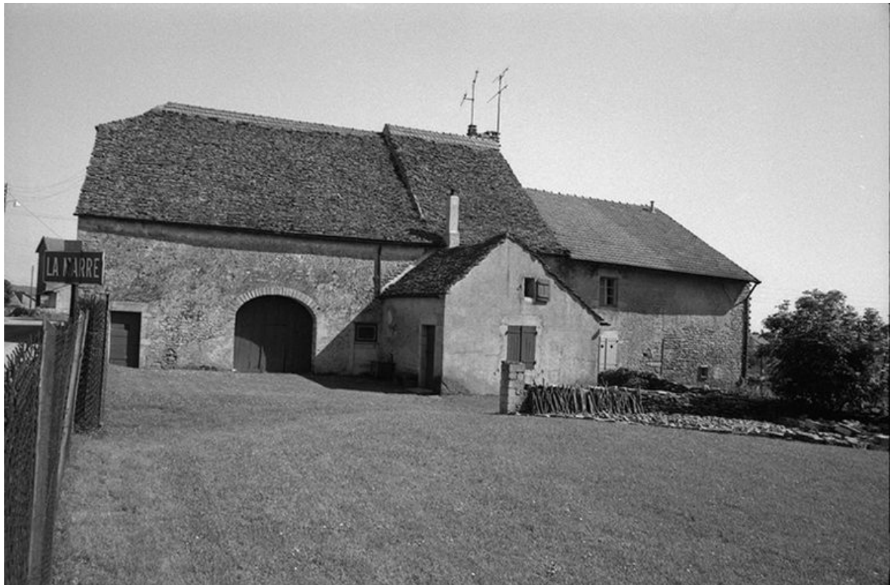
Ferme cadastrée 1957 A1 287 et 293 : vue d'ensemble.
