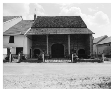
Ferme située rue de Crançot : façade antérieure. Phot. Yves Sancey IVR43_19813900155X
