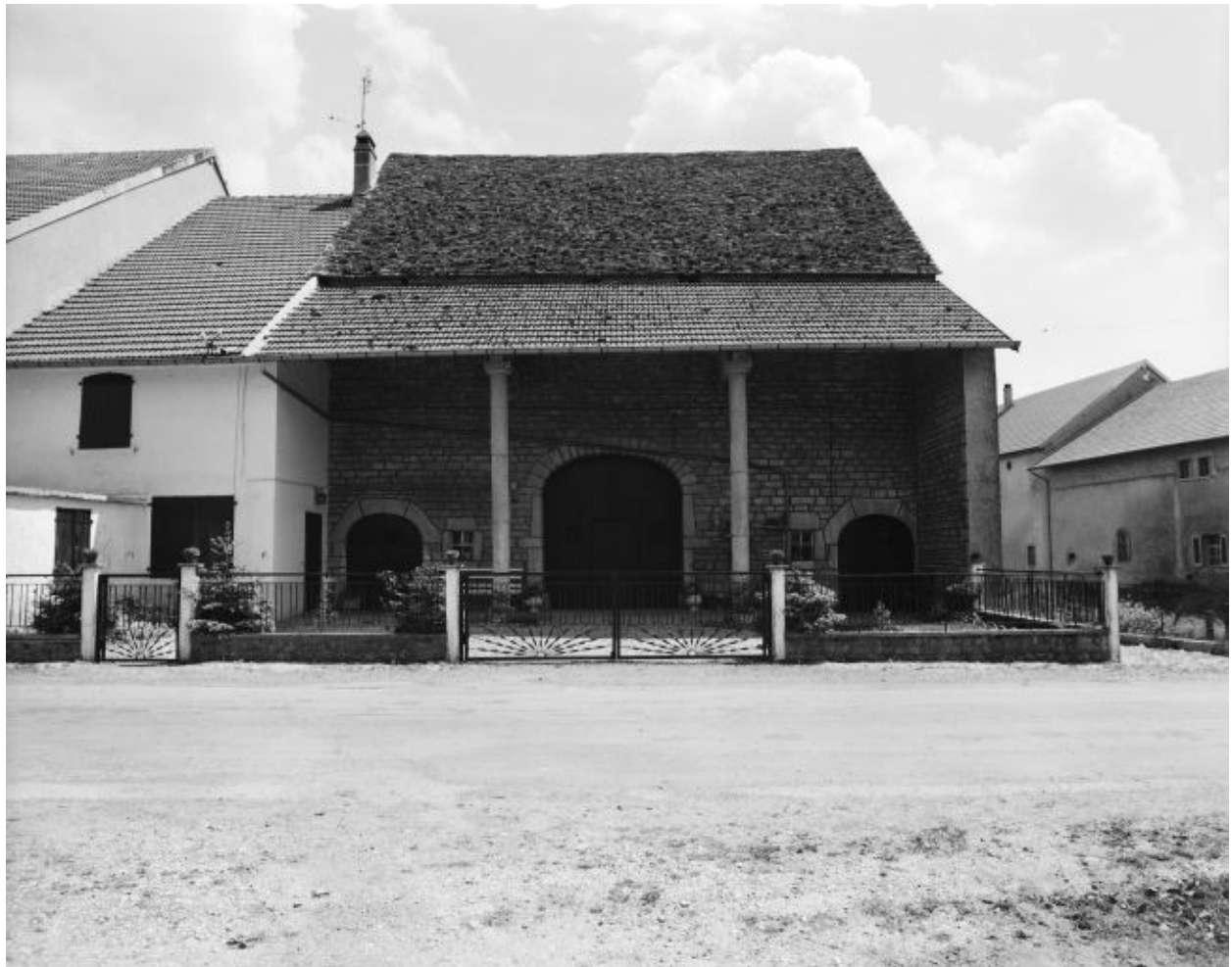
Ferme située rue de Crançot : façade antérieure.
