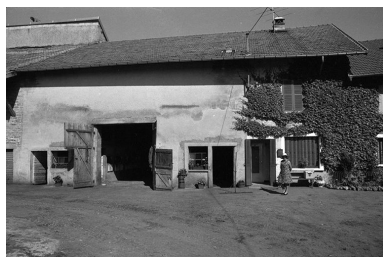
Ferme cadastrée 1957 A1 64 : façade antérieure. Phot. F. Pernin IVR43_19743900195Z
