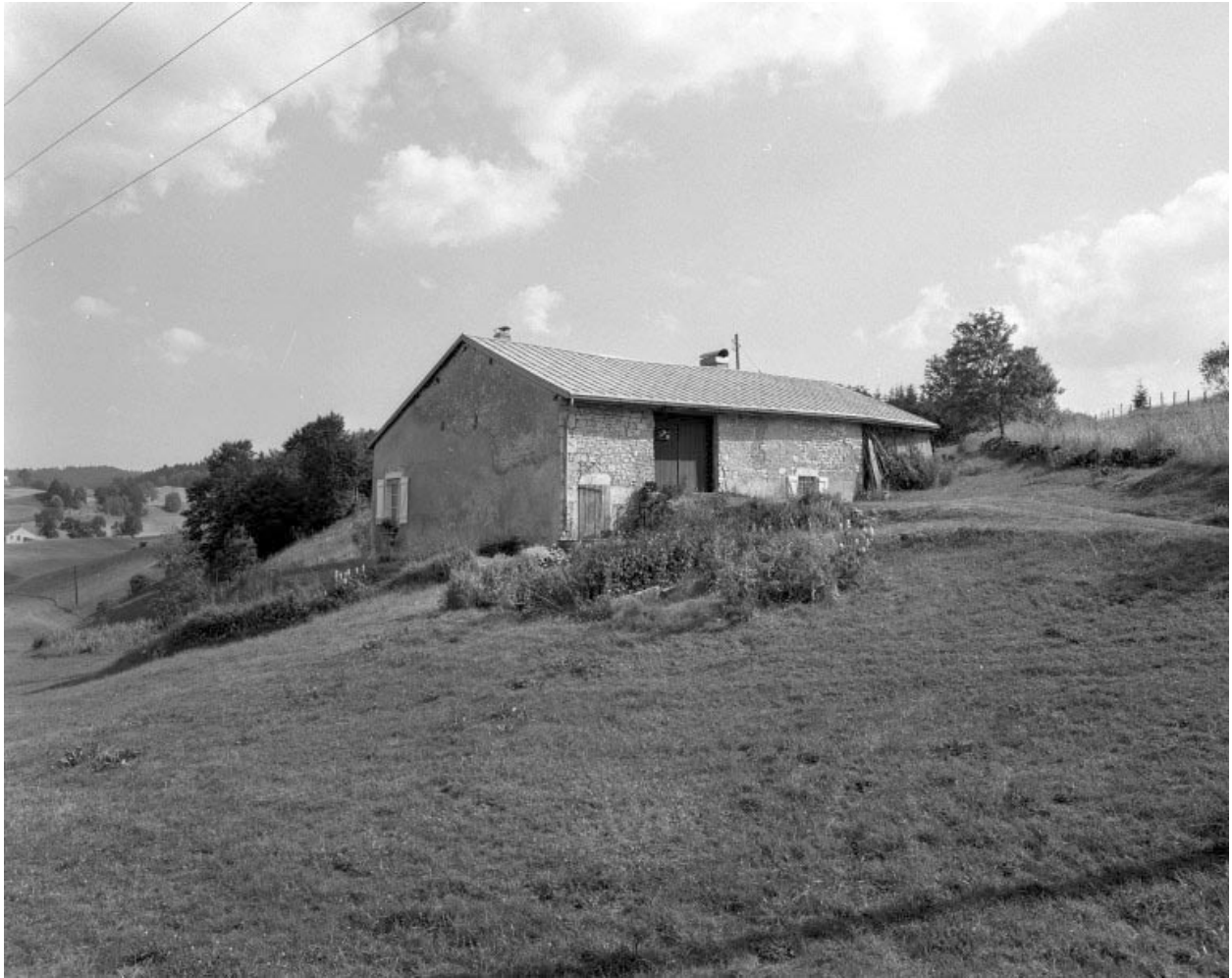
Face droite et façade postérieure.
