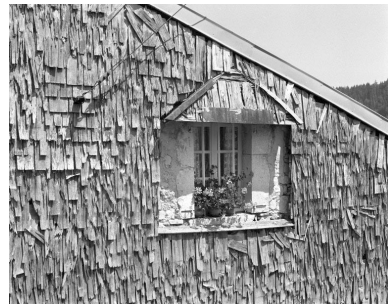
La fenêtre de la face gauche. Phot. Jérôme Mongreville IVR43_19943900772X
