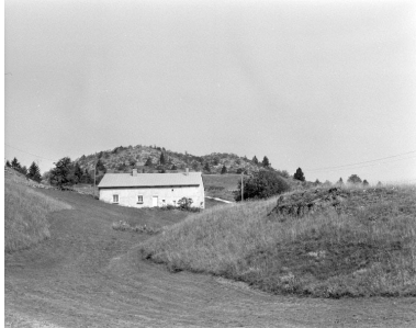
Vue générale, façade antérieure. Phot. Jérôme Mongreville IVR43_19943900777X
