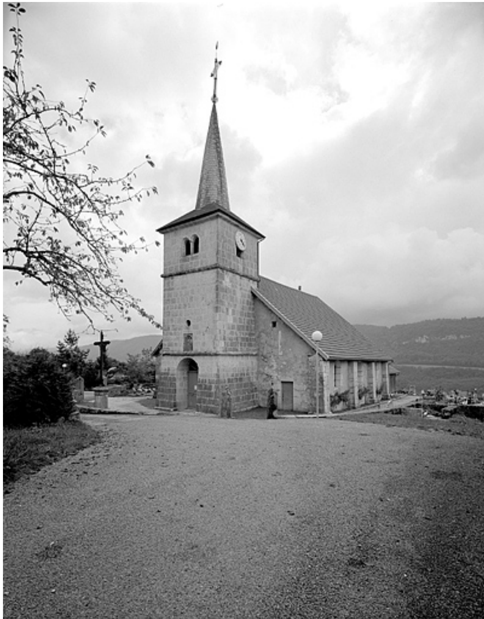
Façade antérieure et face droite.
