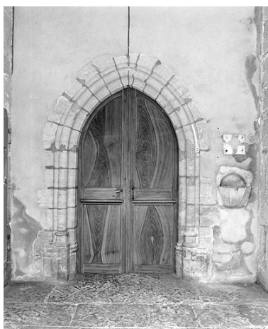
Le portail de la nef. Phot. Yves Sancey IVR43_19963900755X
