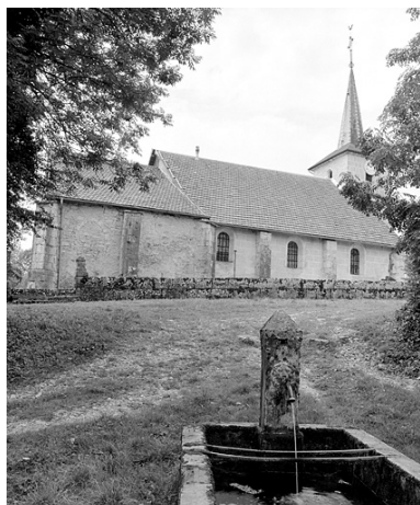
Face gauche, vue depuis le nord-est. Phot. Yves Sancey IVR43_19963900751X
