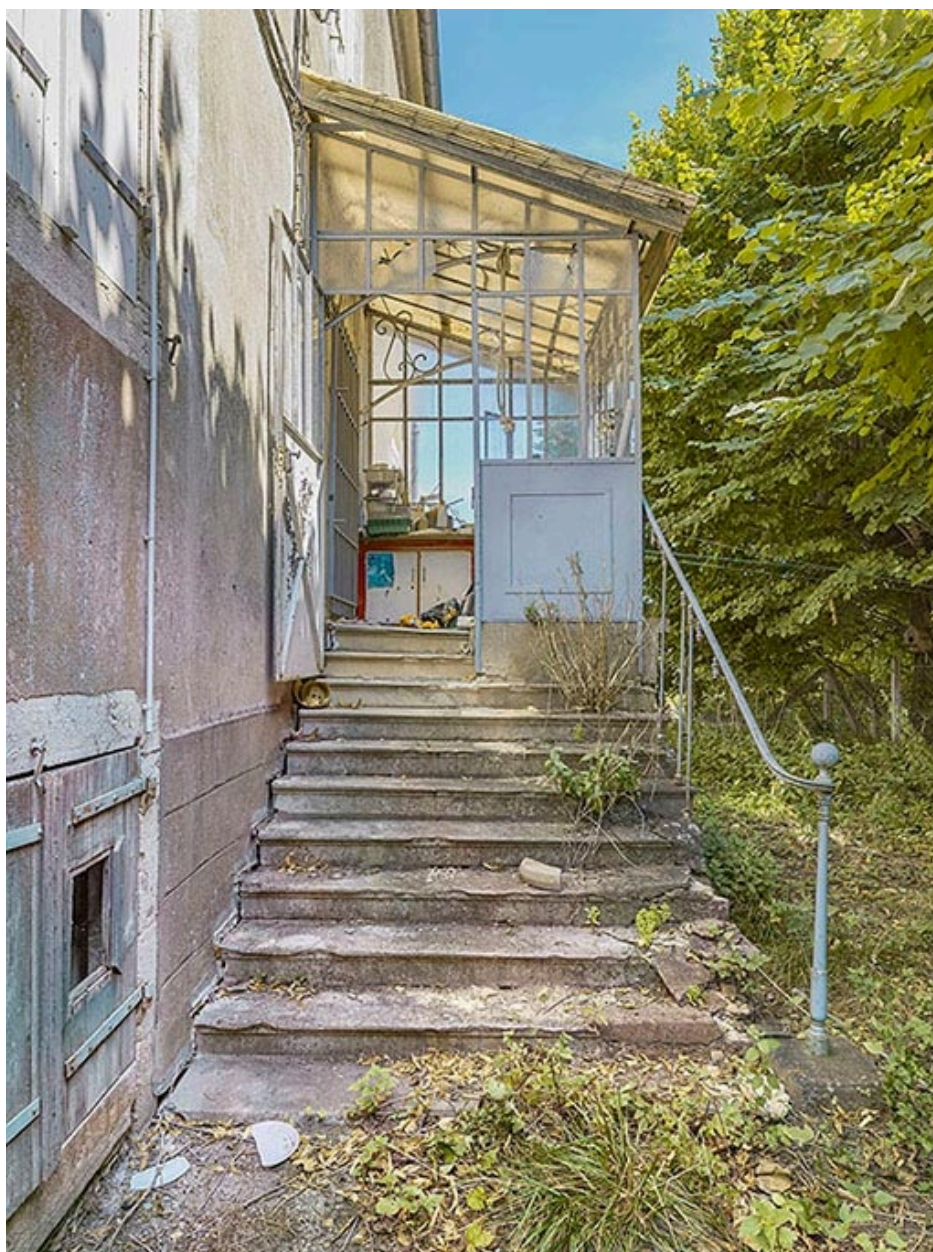
Escalier d'entrée de la maison éclusière.
