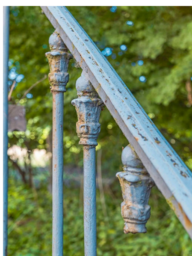
Détail des balustres du garde-corps de l'escalier.
