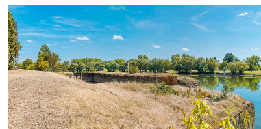
L'ancienne écluse de Verdun au premier plan.
