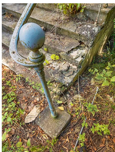
Départ de rampe de l'escalier de la maison éclésièr.
