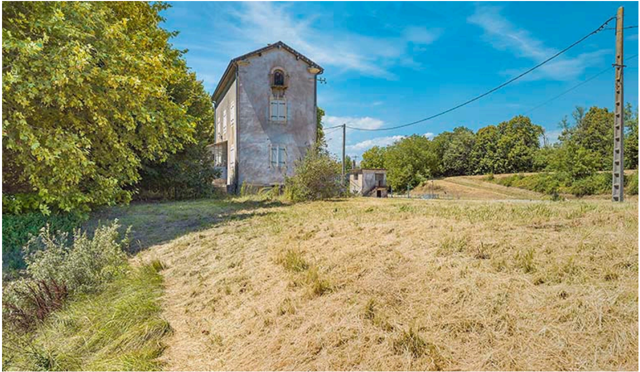
Pignon de la maison éclusière.
