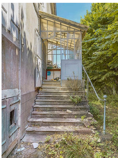
Escalier d'entrée de la maison éclusière.
