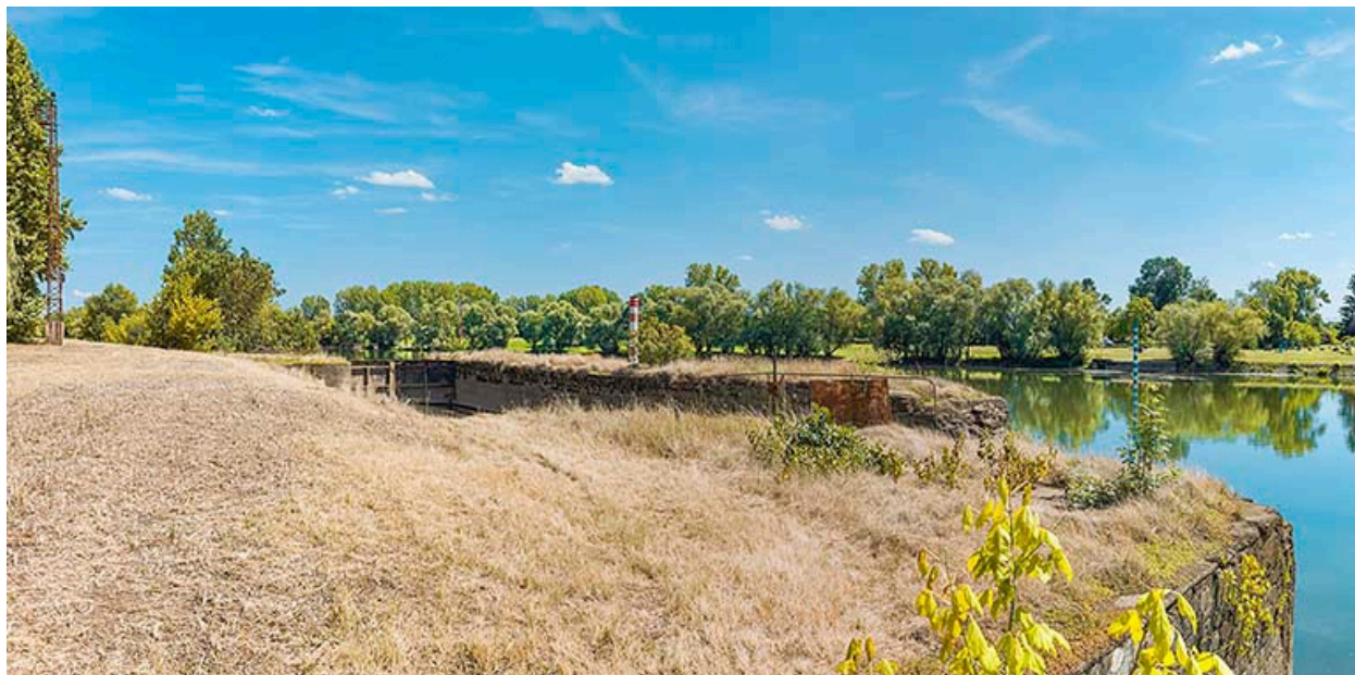
L'ancienne écluse de Verdun au premier plan.
