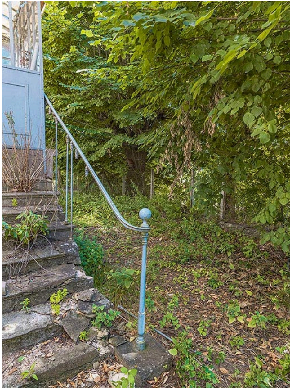
Départ de rampe de l'escalier de la maison éclusière.
