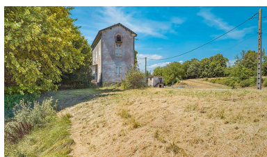
Pignon de la maison éclusière.
