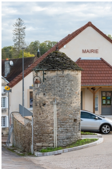
Vue d'ensemble côté ouest. Phot. Pierre-Marie Barbe-Richaud IVR26_20222101055NUC4A
